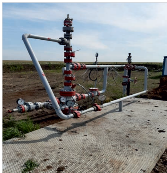
Фото 1. УСУ в устьевой обвязке скважины
