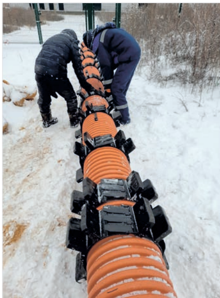
Монтаж ОНК тип AP L на гофрированной трубе
