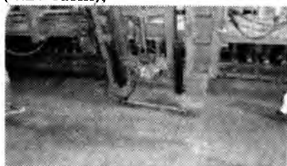
4.27-rasm. Ko'ndalang va bo'yлама choklarga shtirlar va armaturalarning avtomat ravishda o'rnatilishi
