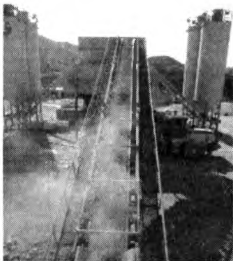
3.7-rasm. Tarozida tortilgan to'ldiruvchilarning lenta orqali qorishtirish bunkeriga uzatilishi
