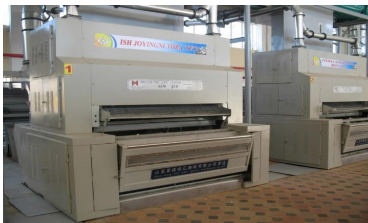
4.4-rasm. Arrali jinlar o‘rnatilgan qatorning umumiy ko‘rinishi
