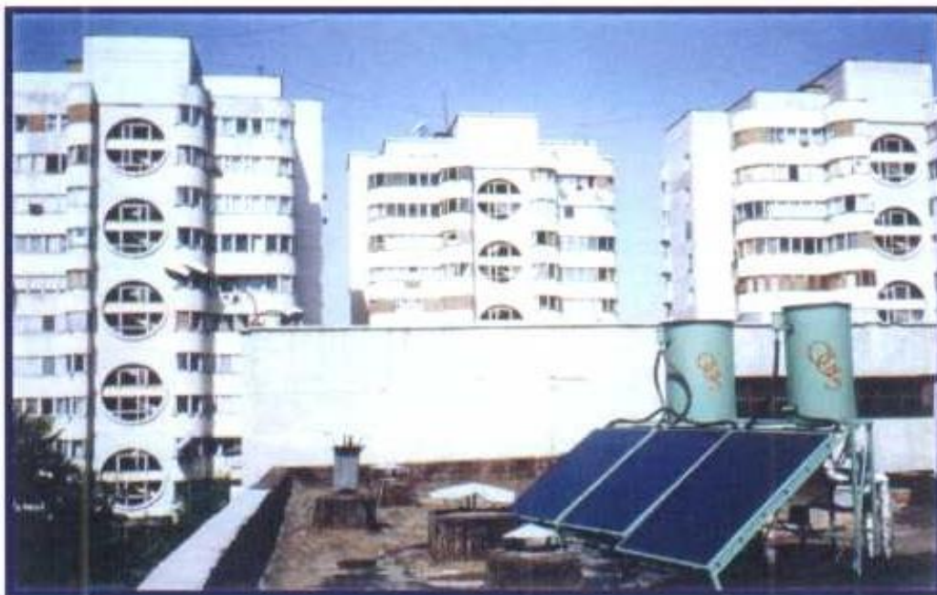
1.2.14-rasm. Toshkent shahrida poliklinika binosi tomiga o‘rnatilgan suv isitgich qurilmalari
