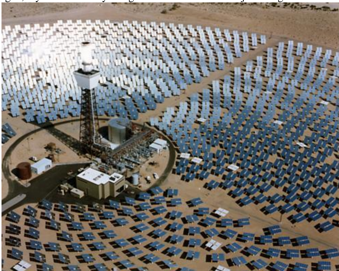
3.1.9-rasm. Minorali kuyoshli elektr stansiyasining umumiy ko'rinishi
