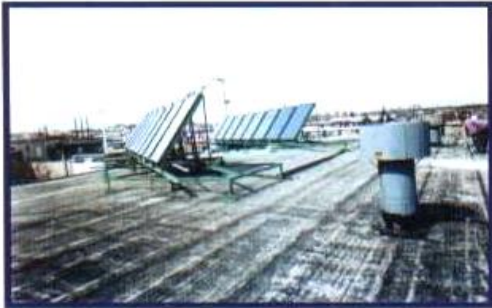
1.2.15-rasm. Temir yo‘l vokzali binosi tomiga o‘rnatilgan suv isitgich qurilmalari
