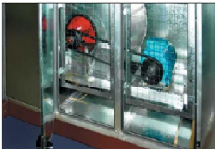
3.33-rasm. Uzatmalar to‘r bilan himoyalangan
