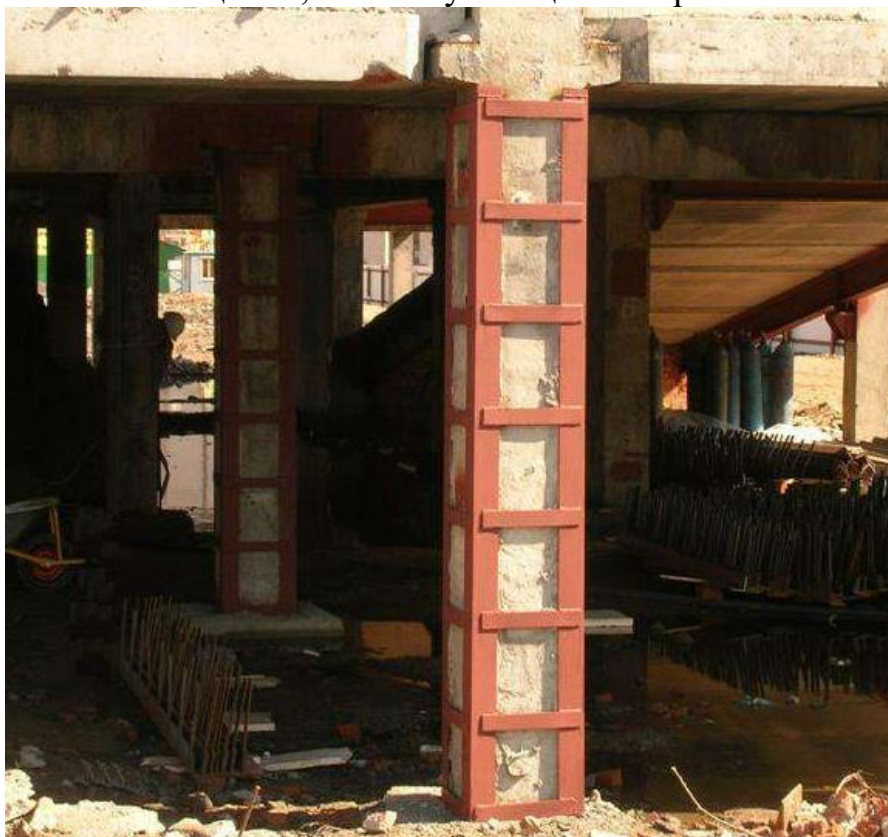
Рис. Пр4.6. Усиление колонн наращиванием с использованием опалубки-облицовки: а – установка арматуры; б – устройство усиления; 1 - колонна; 2 - армокаркас; 3 - бетон омоноличивания; 4 - элементы облицовки; 5 - выступающие анкера
