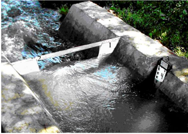
2-расм. Чиполетти водосливи асосидаги гидропост.
