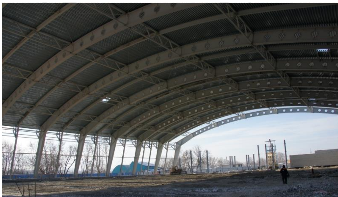
Рис. 2.23. Металлические рамы сплошного сечения пролетом 80 м
