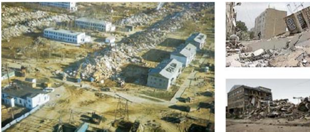
Рис. 3.2. Разрушительные землетрясения на Сахалине и Камчатке (Россия)
