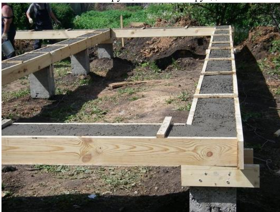
Рис. 1.48. Конструкция свайного фундамента
