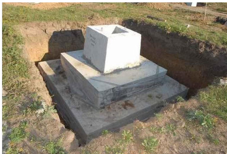
Рис. 1.42. Сборный подколонник и монолитные фундаментные плиты
