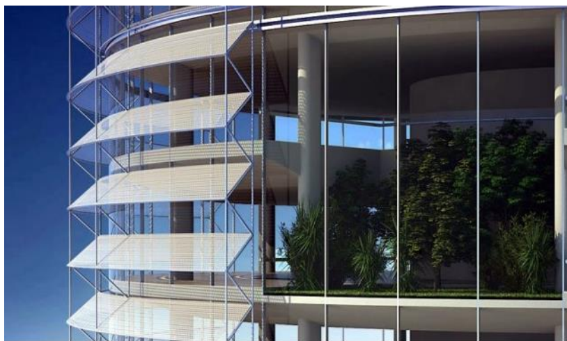
Рис. Пр2.30. Наклонные козырьки
