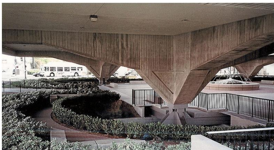
Рис. 3.17. Использование сейсмоизоляции в общественном здании в Калифорнии (США)
