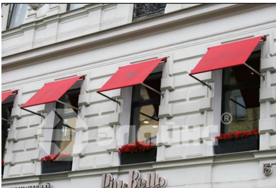
Рис. Пр2.4. Солнцезащитные устройства на окнах
