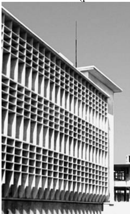
Рис. П2.34. Комбинированные солнцезащитные устройства
