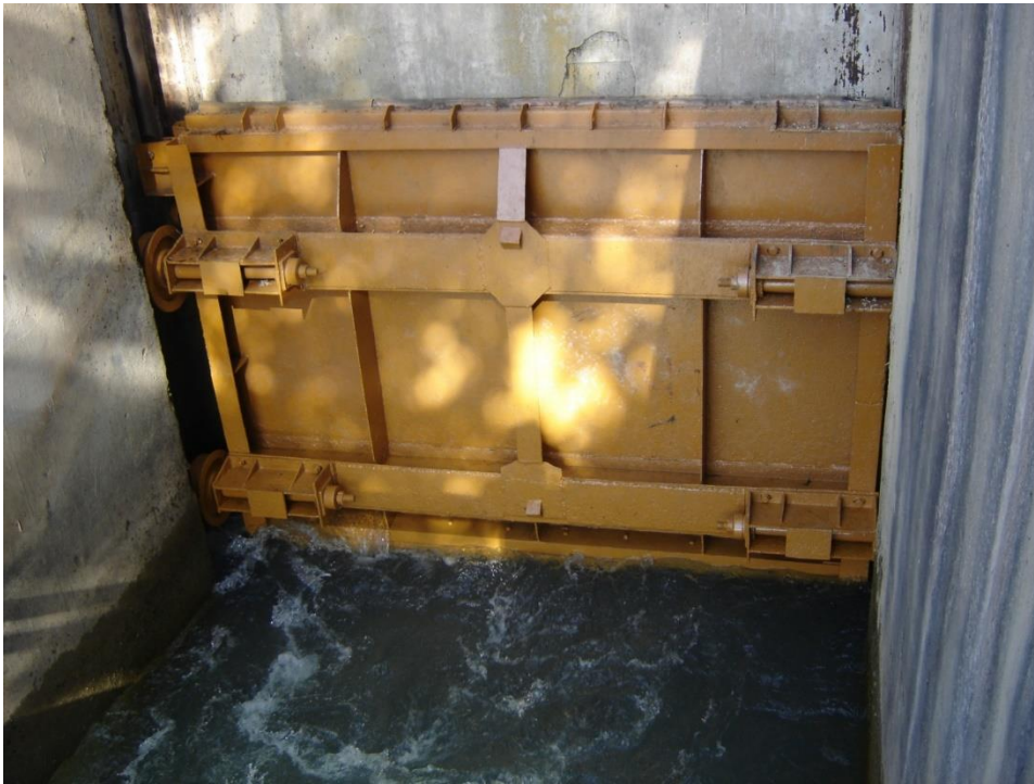
3.15 - расм Катта Фарғона каналнинг бош иншоотида ўрнатилган ясси затворларни пастки бѐфдан кўриниши.
