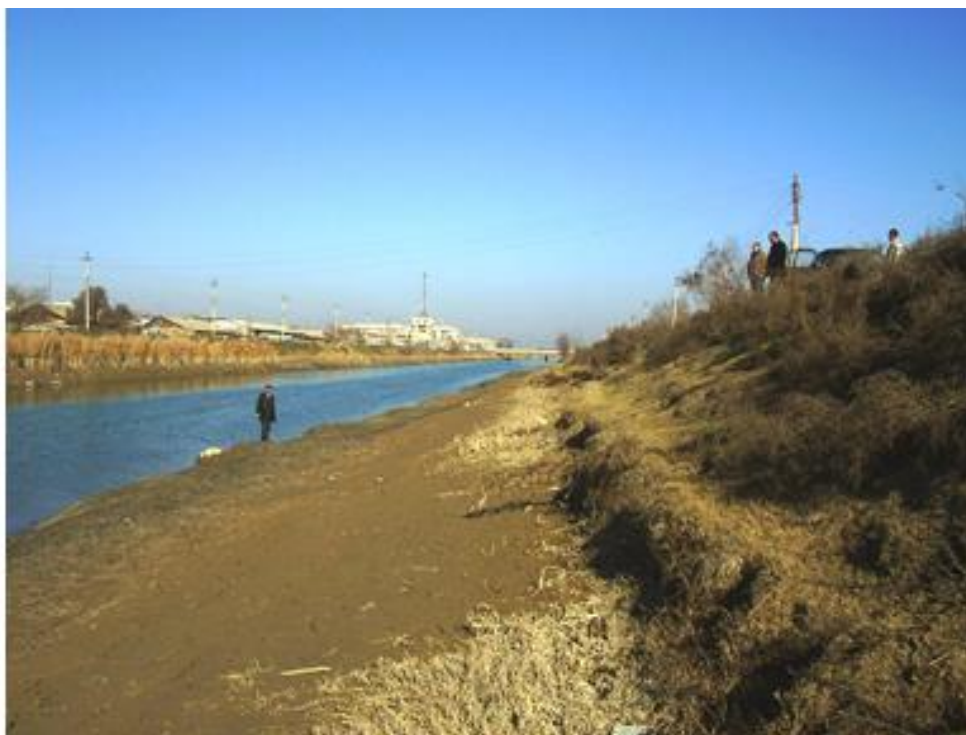
3.8. - расм. Дўстлик каналининг қабарик қисмидаги лойқа чўкиш ҳолати
