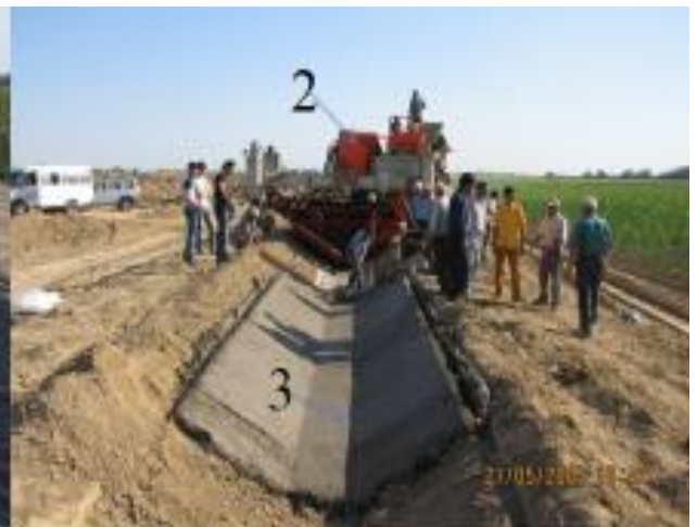
3.12 - расм. Канал ўзанини бетонлаш:
