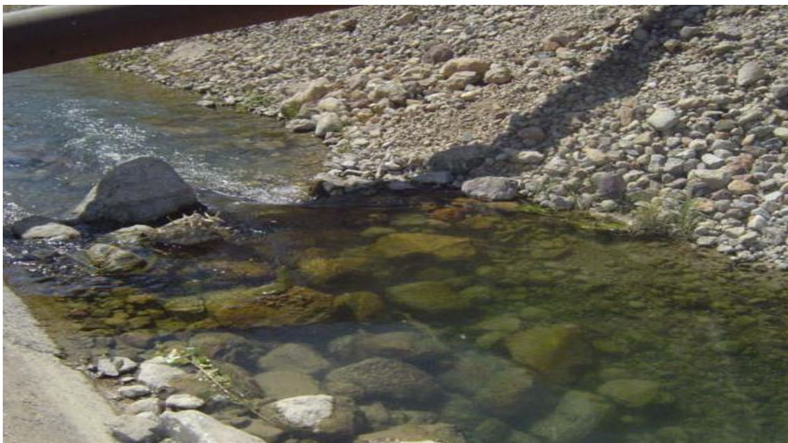
3.9 – расм. Тоғ ён-бағридан ўтган канал ўзанини тош босиши ҳолати.
