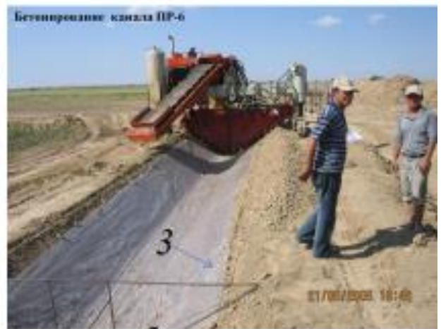
3.11 - расм. Канал ўзанини бетонлашга тайёрлаш:
