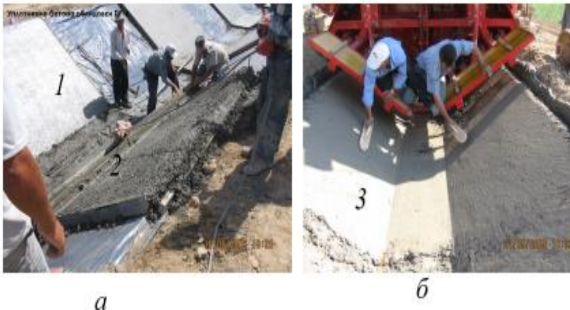
3.13- расм. Бетон қопламасига ишлов бериш: а) тебранувчи рейка билан зичлаш; б) гусенецали бетон ётқизгич; 1 – бетон қоплама; 2 – тебранувчи рейка; 3 - бетон ётқизгич ҳосил қилган қоплма.
