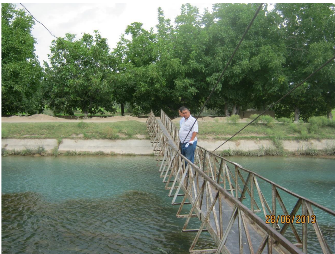
3.4 - расм. Янги Учқурғон канали ўзанида ўсган сув ўтлар
