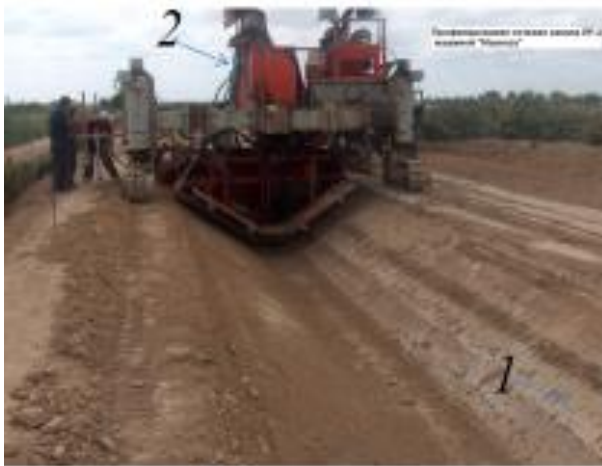
3.11 - расм. Канал ўзанини бетонлашга тайёрлаш:
