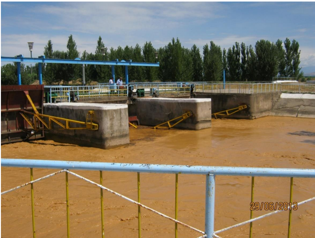
3.16 - расм Катта Фарғона каналига ўрнатилган сегментли затворларни пастки бѐфдан кўриниши.
