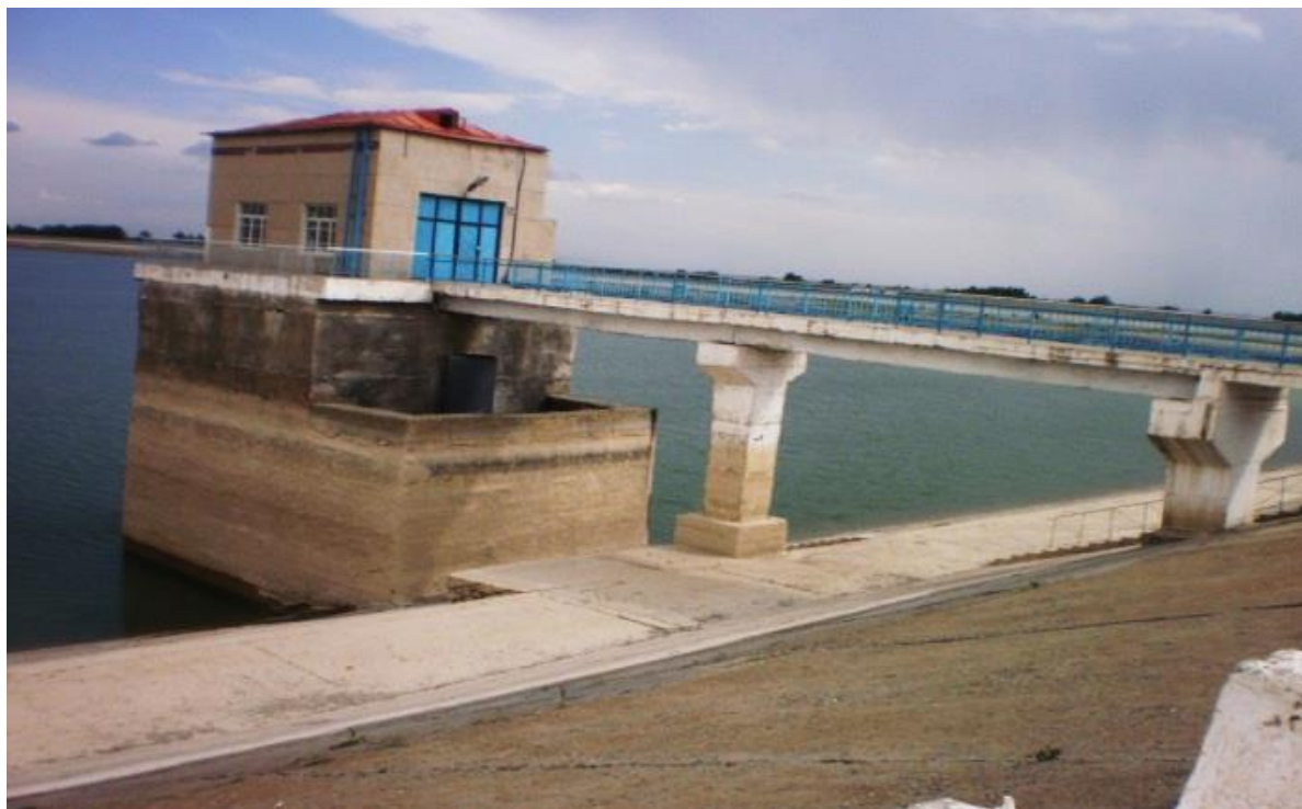
2.1 - расм. Ок дарё сув омборидаги сув чиқазгич ва сув ташлагич иншооти.
