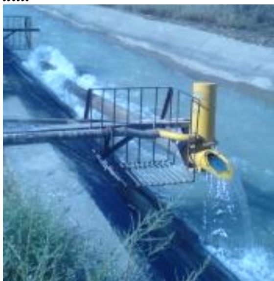
3.7-расм. Канал нишаблиги ҳисобига ўрнатилган гидротаран.
