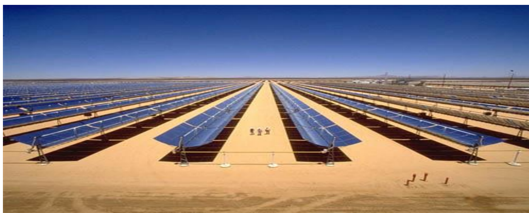
1.6 -расм. Дунёдаги энг катта қуёш электростанцияси.
