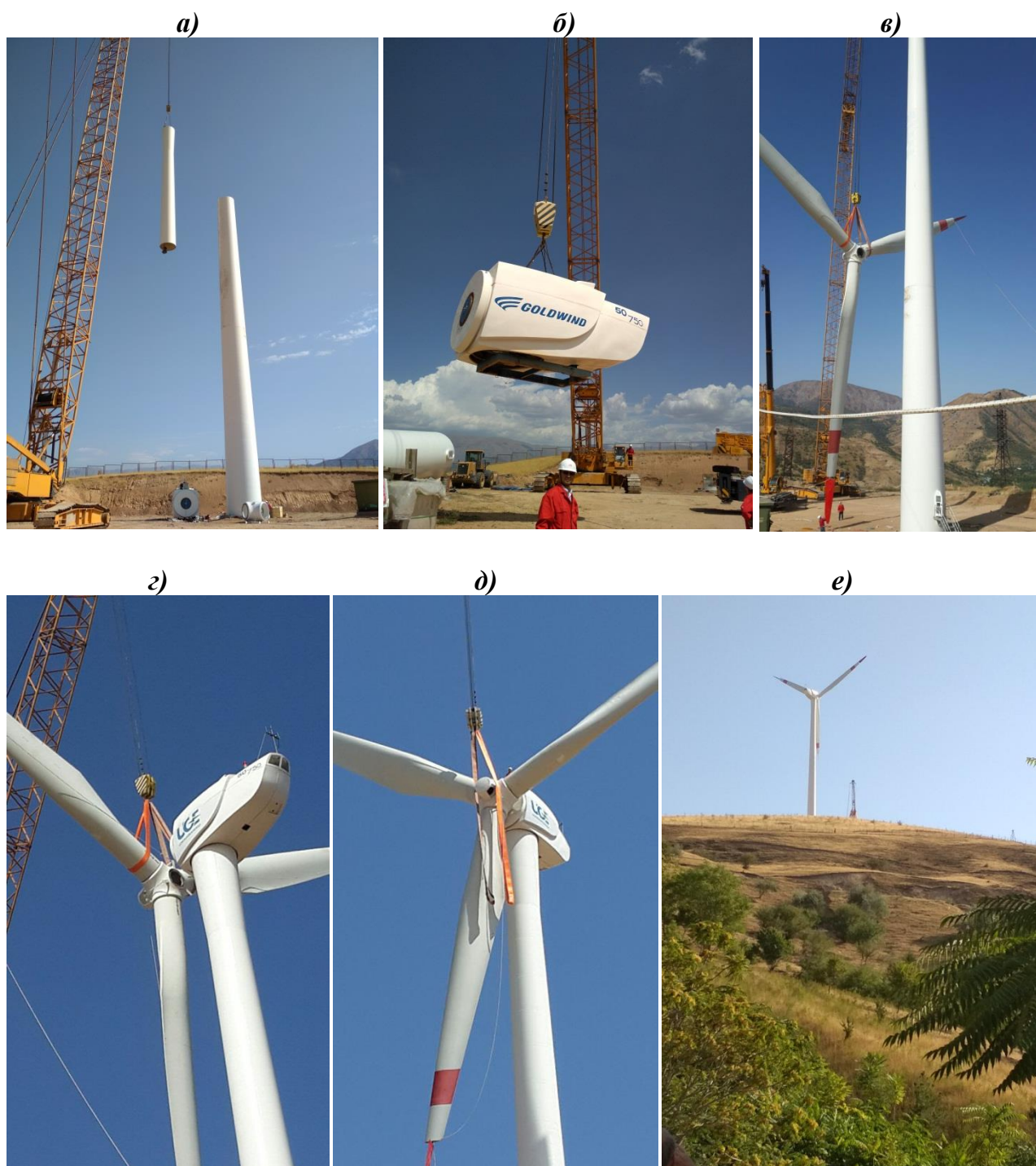
4.9-расм. Жанубий Кореянинг «Doojin Co. LTD» компанияси ёрдамида, Чорвоқ сув омборининг дам олиш зонасида шамол энергоқурилмасини ўрнатиш жараёни
