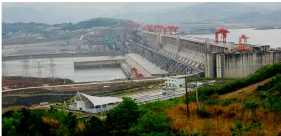
1.2-расм. Дунёдаги энг катта Уч дара гидроэлектростанцияси
