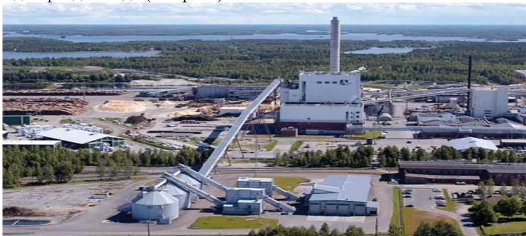
1.8 -расм. Дунёдаги энг катта биомасса ёқувчи станциянинг кўриниши.
