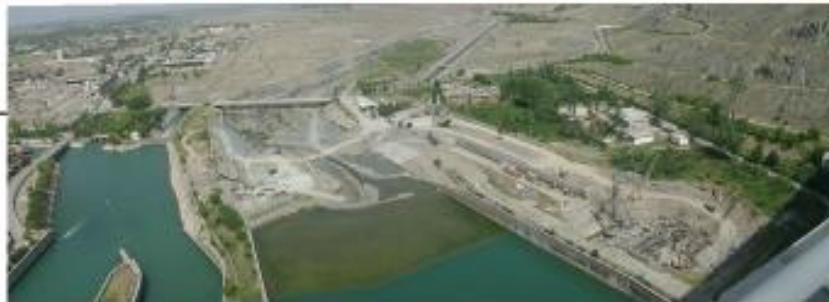
Фото 1. Строительство малой ГЭС: котлован под здание ГЭС, отводящий канал с выпуском в р. Карадарья, докер под р. Карадарья с подключением к каналу Шаркиансай.
