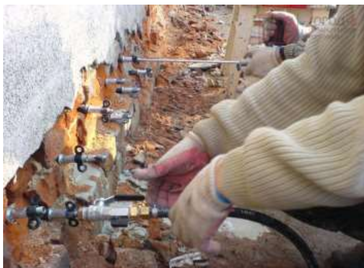
Рис. Пр5.5. Инъектирование каменной кладки ремонтными растворами
