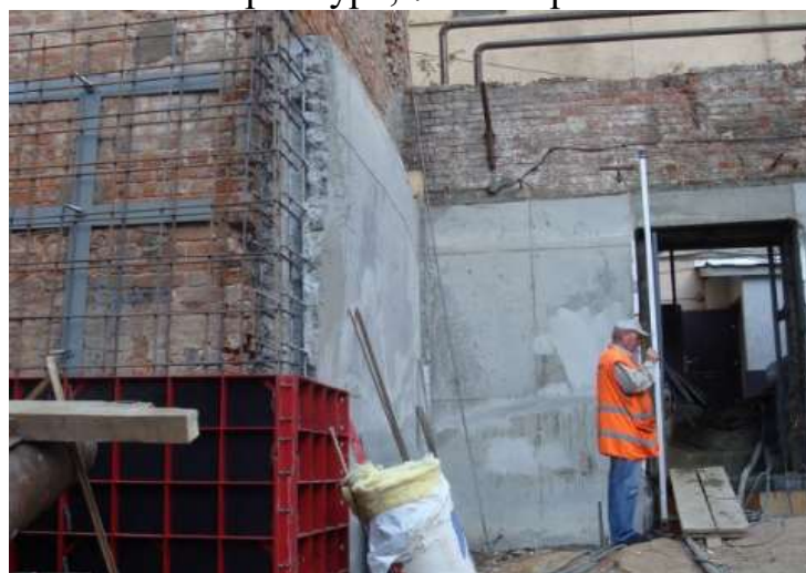
Рис. Пр5.2. Усиление железобетонной обоймой: а – столбов, б – простенков: 1 – усиливаемая конструкция, 2 – продольная арматура, 3 – поперечная арматура, 4 – бетон, 5 – дополнительные поперечные связи, 6 – продольная арматура, 7 – анкеры
