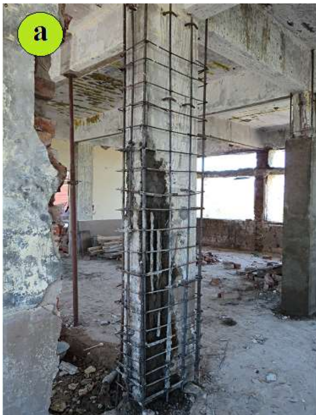
Рис. Пр4.6. Усиление колонн наращиванием с использованием опалубки-облицовки: а – установка арматуры; б – устройство усиления; 1 - колонна; 2 - армокаркас; 3 - бетон омоноличивания; 4 - элементы облицовки; 5 - выступающие анкера
