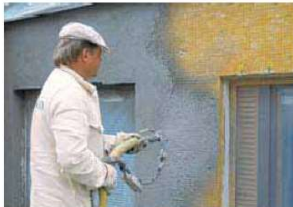
Рис. 4.5. Работы по устройству дополнительной теплоизоляции с толстослойной штукатуркой
