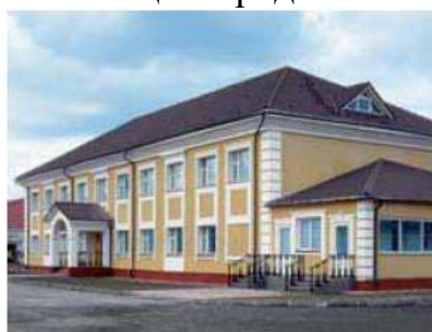
г. Москва, строительный трест. Теплоизоляция ISOVER FASOTERM PF.
