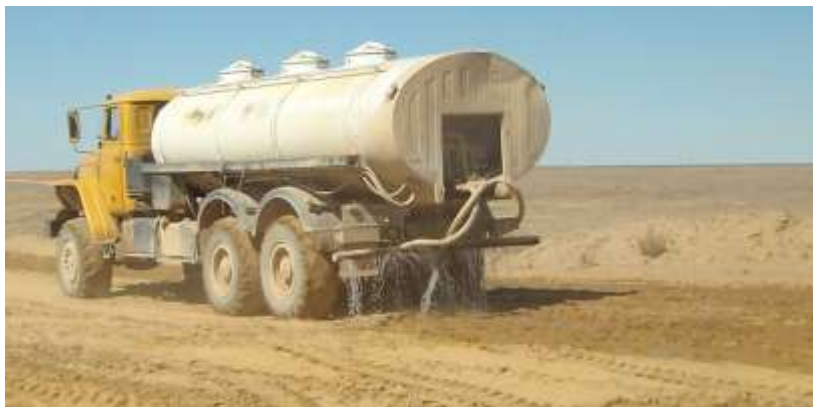
14- rasm. Grunt namligini optimal qiymatga yetqazish uchun suv sepish jarayoni
