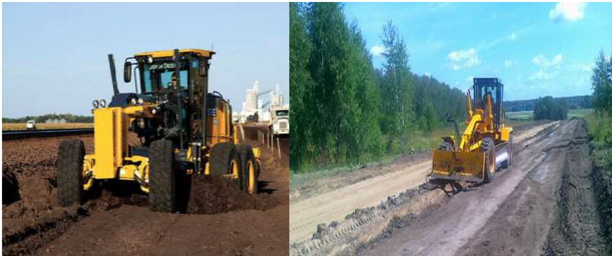
13-rasm. Og'ir va o'rta avtogreyderlar bilan yo'l poyini qurish
