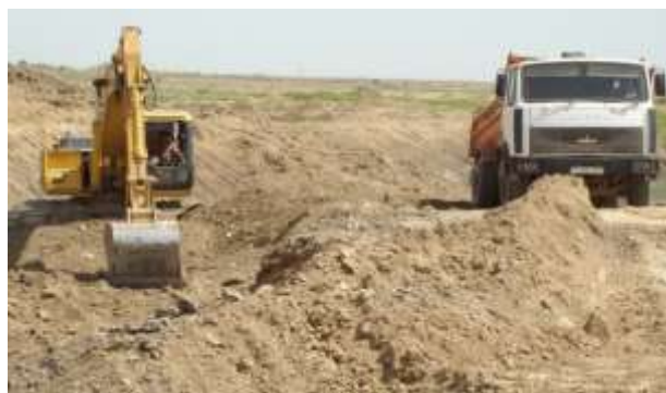
9-rasm Gruntni rezervda ekskavator bilan qazib avtosamosvalga ortish
