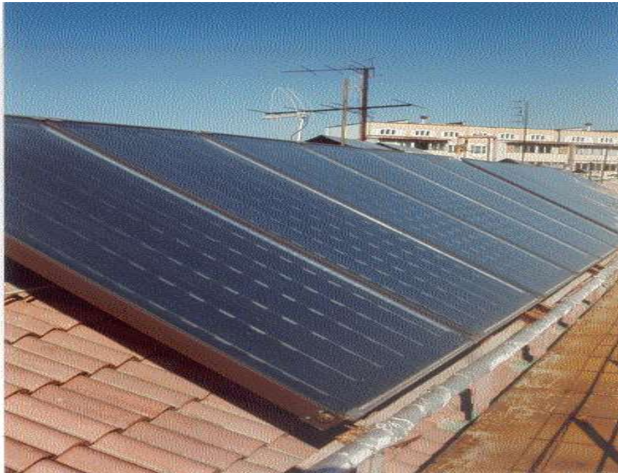
3.1.4-rasm. TACIS loyihasi bo'yicha monitoring o'tkazilgan Chexov kuchasidagi namoyish binosining tomida joylashgan quyosh kollektorlari
