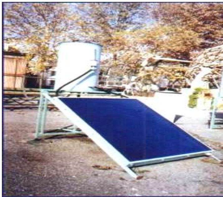
1.2.12- rasm. Quyosh isitgichining sathi 2 m 2 va issiq suv jamlovchi bakining hajmi 140 l bo‘lgan 2 konturli suv isitgich qurilma
