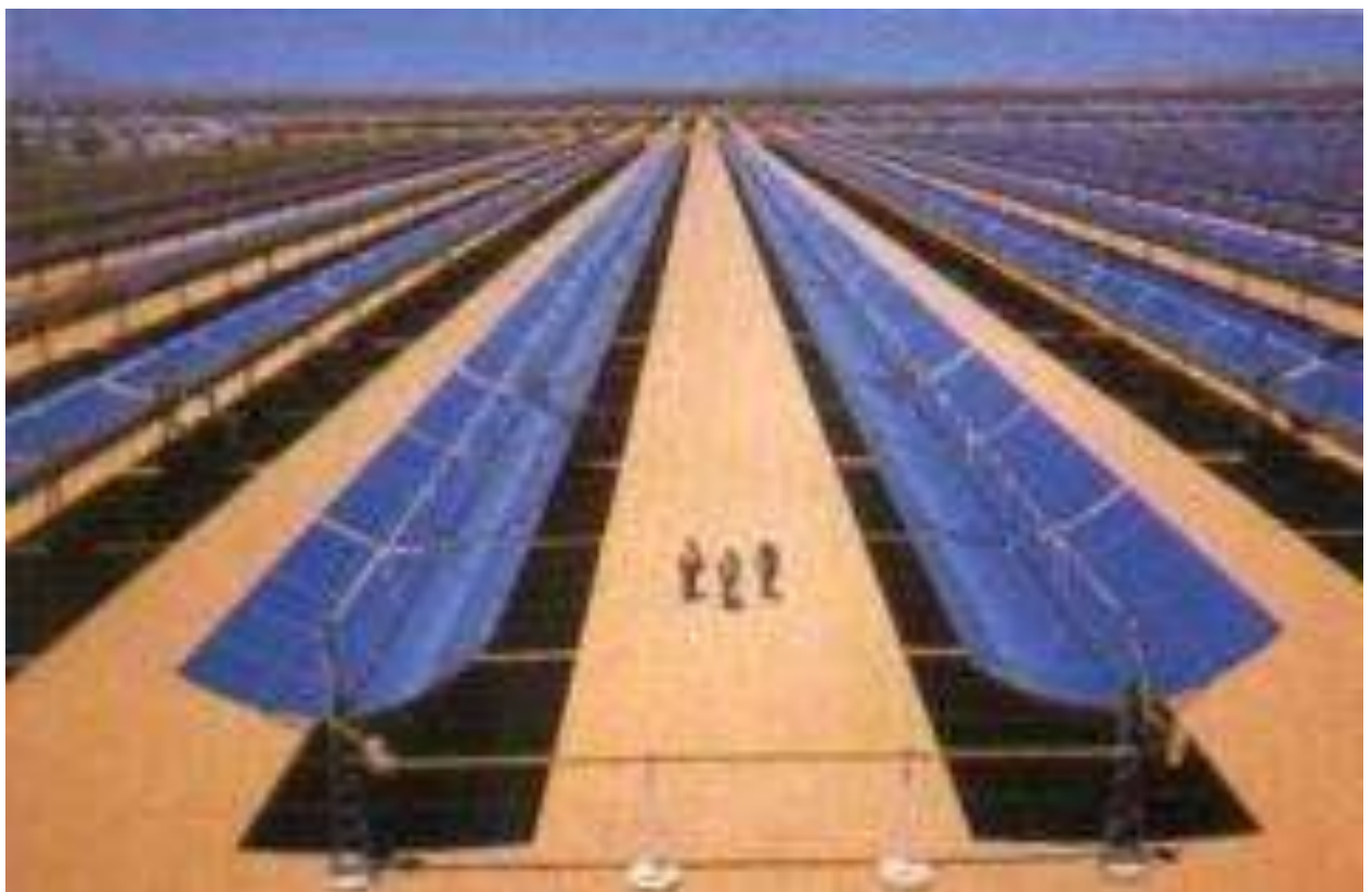
3.1.7-rasm. Parabolasimon geliokonsentratorlar bilan jihozlangan quyoshli elektr stansiyaning geliomaydonning ko‘rinishi.
