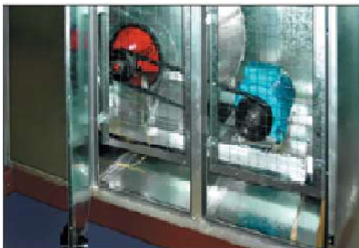
3.33-rasm. Uzatmalar to‘r bilan himoyalangan
