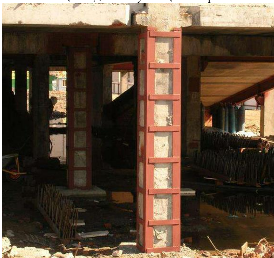
Рис. Пр4.6. Усиление колонн наращиванием с использованием опалубки-облицовки: а – установка арматуры; б – устройство усиления; 1 - колонна; 2 - армокаркас; 3 - бетон омоноличивания; 4 - элементы облицовки; 5 - выступающие анкеры
