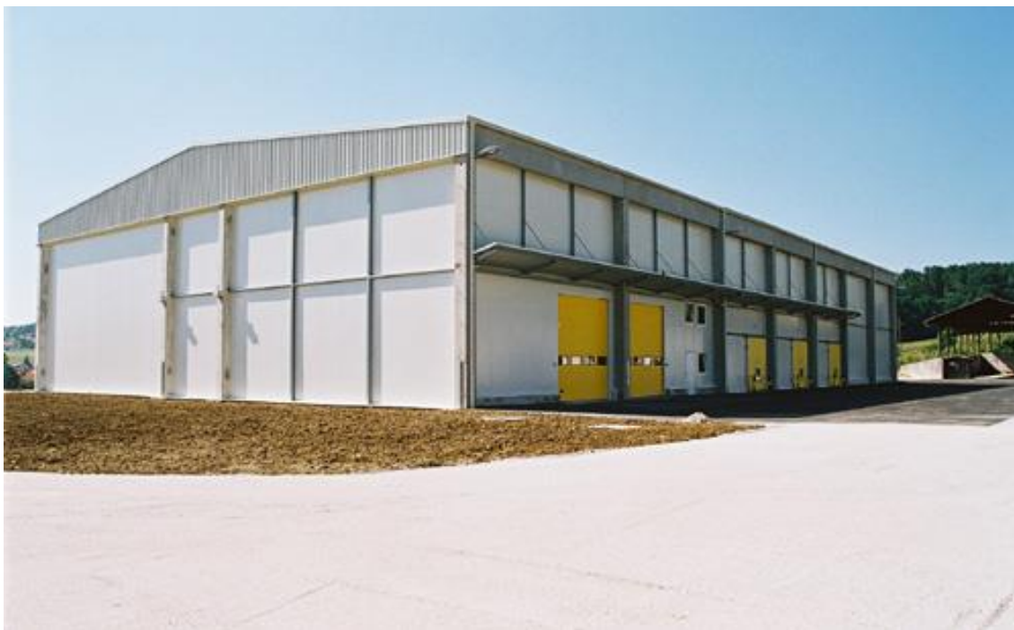
1-расм. Вақтинча тўкиб қўйиш, саралаш, қуришиш учун бостирма ва майдончага эга бўлган замоनावий сабзавот омбори
