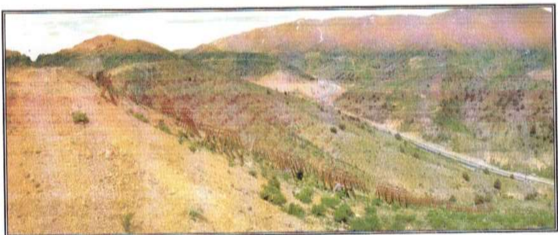
Снегоудерживающие щиты на 166-167 км автодороги Ташкент – Ош. Фото С. В. Карандаева
