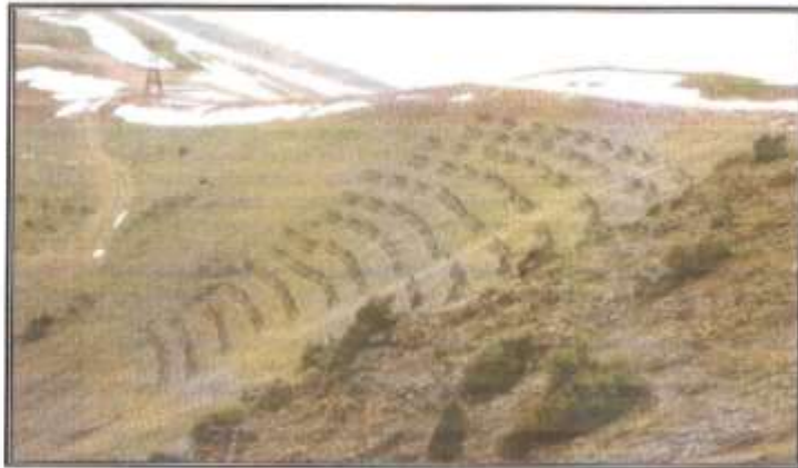
Общий вид поля снегоудерживающих щитов в зоне отрыва лавин. Фото С. В. Карандаева
