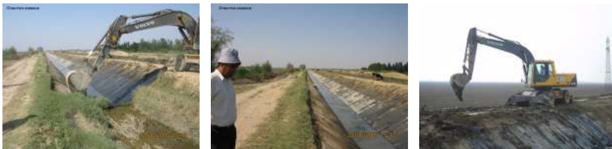
3.6- расм. Қопламали каналларни махсус чўмичли экскаватор билан тозалаш технологияси
