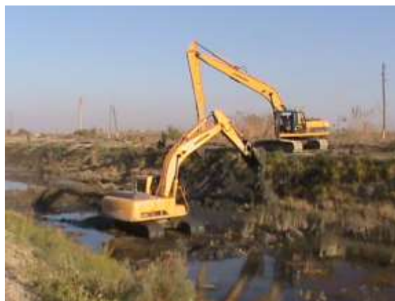
5.8-расм. №4 технологик схема бўйича коллектор ўзанини тозалаш кўриниши
