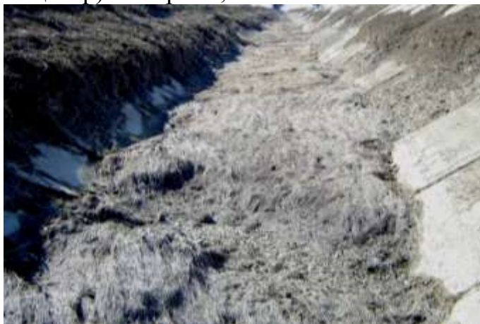
5.10-расм. Қопламали каналларда ўсган, барглари сув ичида бўладиган сув ўсимликлари кўриниши
