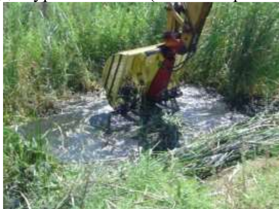
5.12-расм. Дағал пояли ўсимликларни бир чўмичли гидравлик экскаваторлар ва уларга илиниб ишлайдиган ковш ўргич билан сув остидан ўриб тозалаш.
