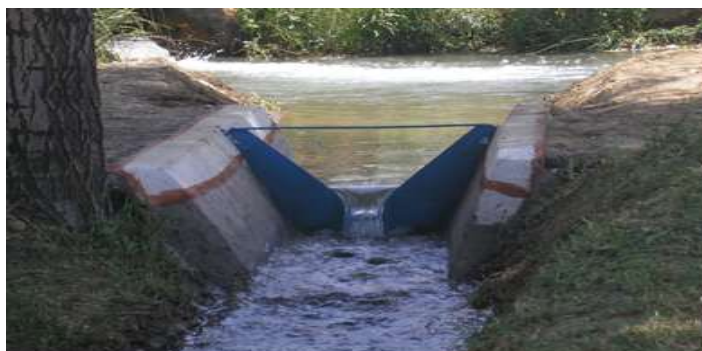
1-расм. Томсон водосливи асосидаги гидропост
