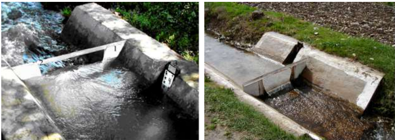
2-расм. Чиполетти водосливи асосидаги гидропост.
