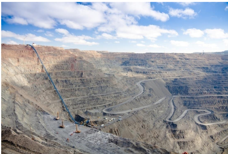
2. Расм. Карьерда юк кўтарувчи конвейрни қўллаш.
