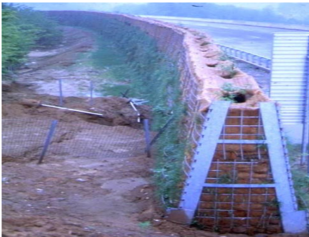
10-расм. Ичи тупроқ билан тўлдирилган темир тўсиқли конструкция
