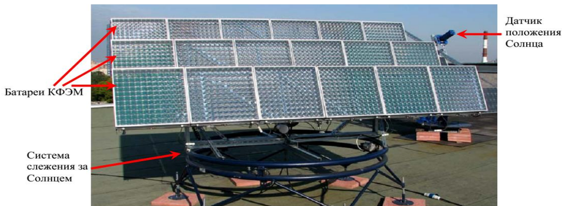
3-сүүрет. 1 кВт қуәатлықтағы концентраторлы қуәш фотоэлектрлик станциясы.
