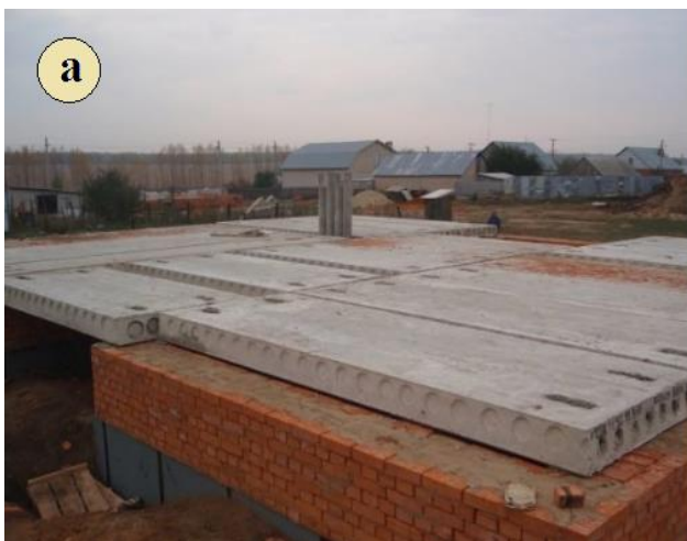
Рис. Пр1.2. Виды перекрытий по технологии изготовления: а – сборное; б- монолитное
