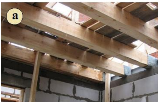
Рис.Пр1. 3. Расстановка деревянных балок перекрытия: а – на стройплощадке; б – в плане
