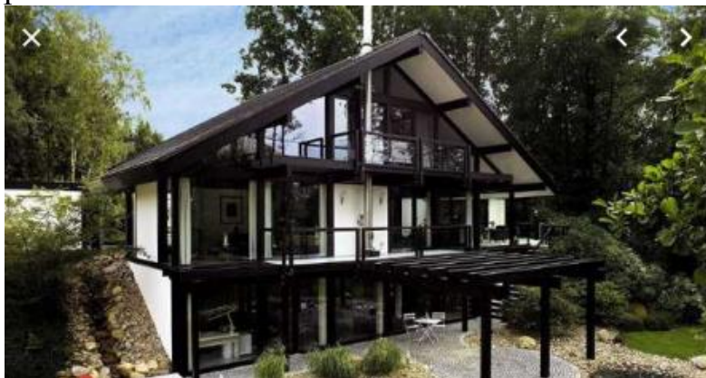
Рис.В2.2. Деревянный каркасный дом по немецкой технологии
