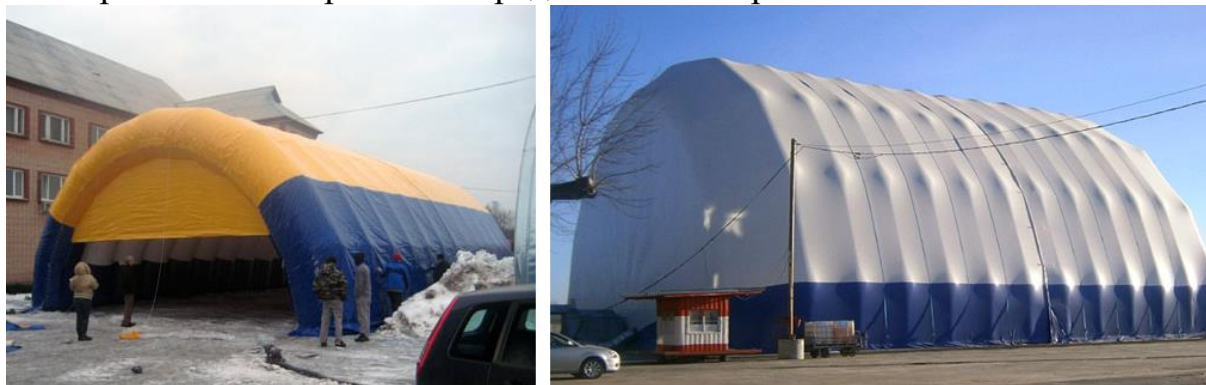
Рис. 2.53. Сооружения с пневмокаркасным покрытием
