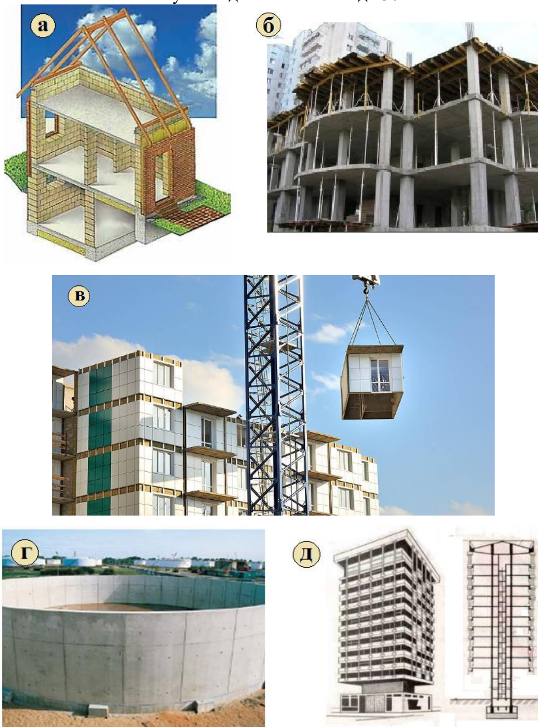
Рис. 1.6. Основные конструктивные системы гражданских зданий: а – бескаркасная (стеновая); б – каркасная; в – объёмно-блочная; г – оболочковая; д – ствольная
