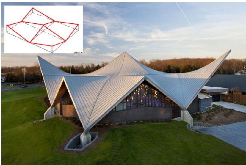
Рис. 2.42. Шатровый блок из четырёх гипаров
