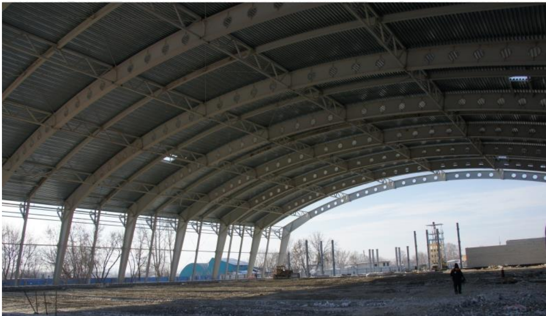
Рис. 2.23. Металлические рамы сплошного сечения пролетом 80 м
