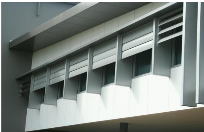
Рис. Пр2.6. Стационарные солнцезащитные устройства комбинированного типа
