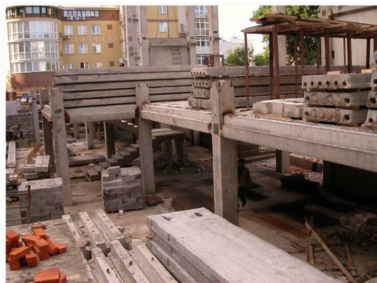
Рис. 1.65. Возведение здания из каркаса серии 1.020.1/87
