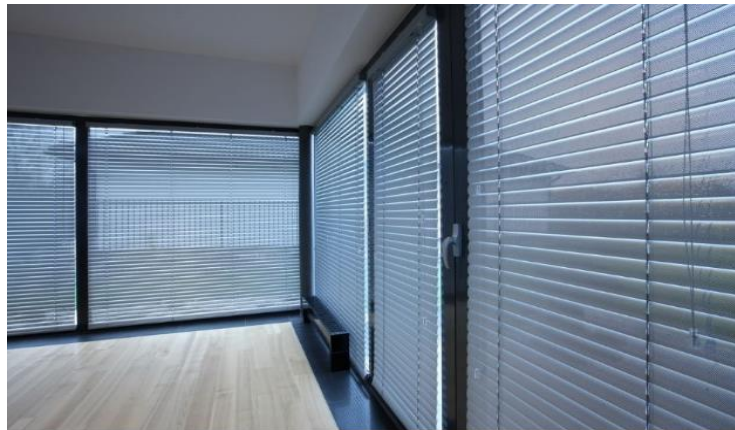
Рис. Пр2.32. Жалюзи с ламелями из зеркальных профилей
