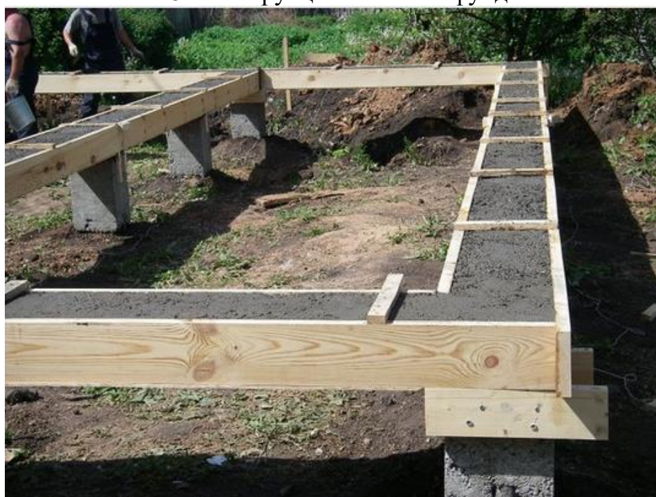
Рис. 1.48. Конструкция свайного фундамента
