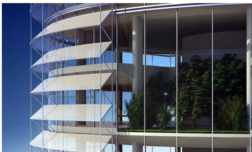
Рис. Пр2.30. Наклонные козырьки
