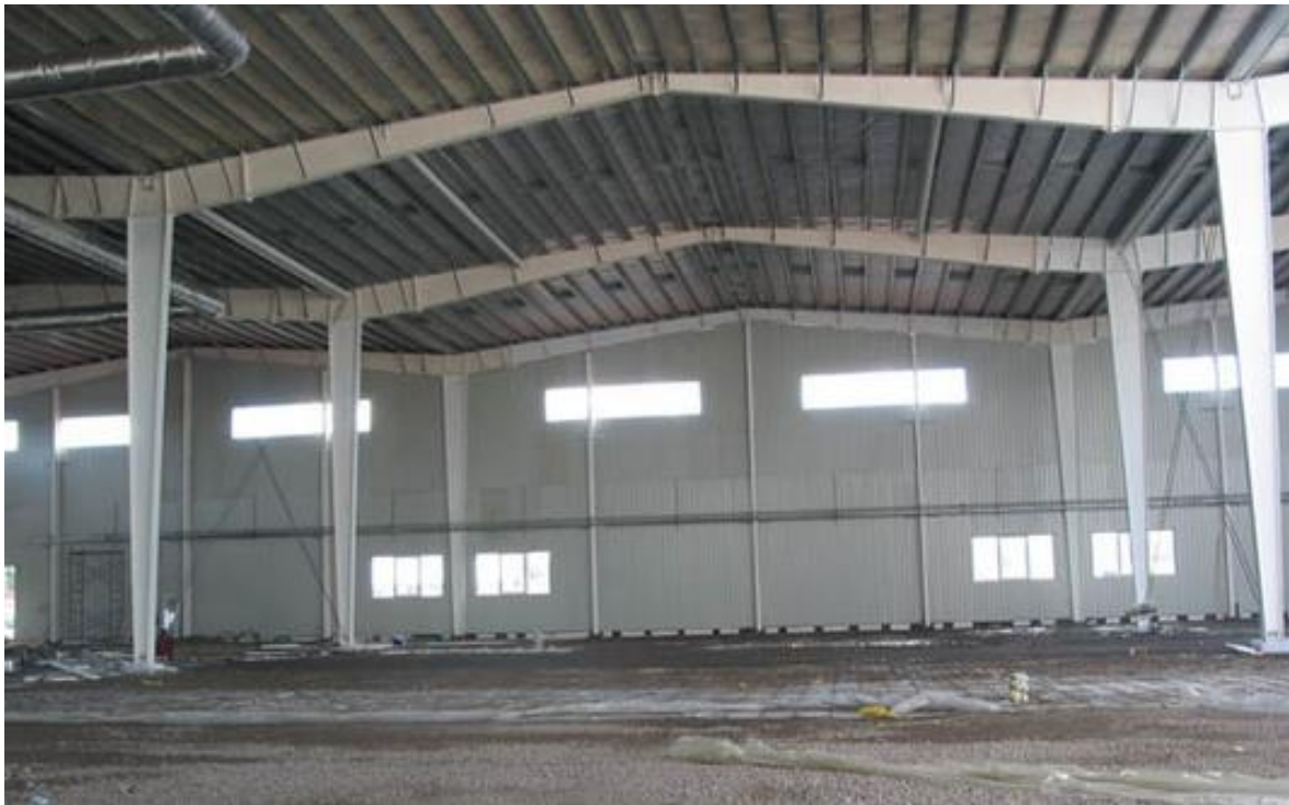
Рис. 2.22. Трёхшарнирная рама сплошного сечения с консолями
