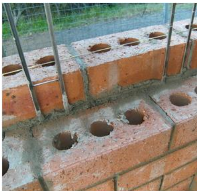
Рис. 1.64. Вертикальное армирование кладки
