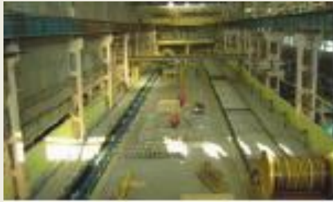
Цех по выпуску сборного железобетона для каркасно-монолитной технологии,
