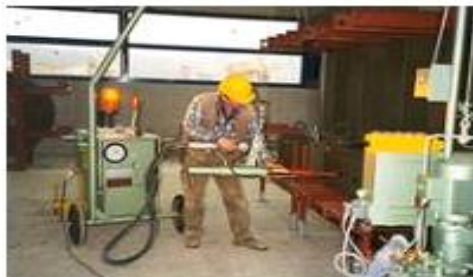
Насос агрегати ва зўриқишни тушириш учун тўрт цилиндр
