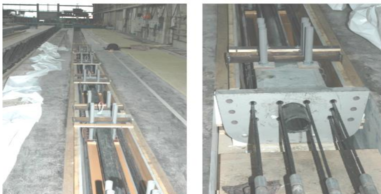
The Gärtnerplatz Bridge Precast UHPC Element for upper chords
