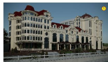
Общий вид (1-очередь строительство)
