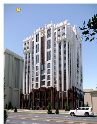
Общий вид (2-очередь строительство)
