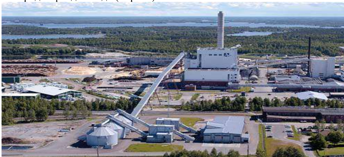
8 -расм. Дунёдаги энг катта биомасса ёқувчи станциянинг кўриниши.
