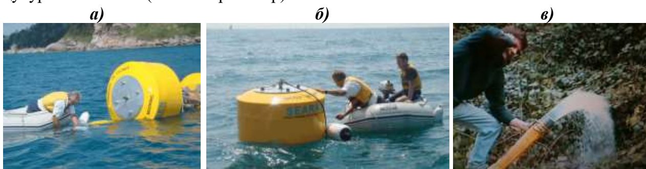
48-расм. Поршенли пўкакларни ўрнатиш жараёни (а ва б) ва ундан чиқаётган сув (в)
