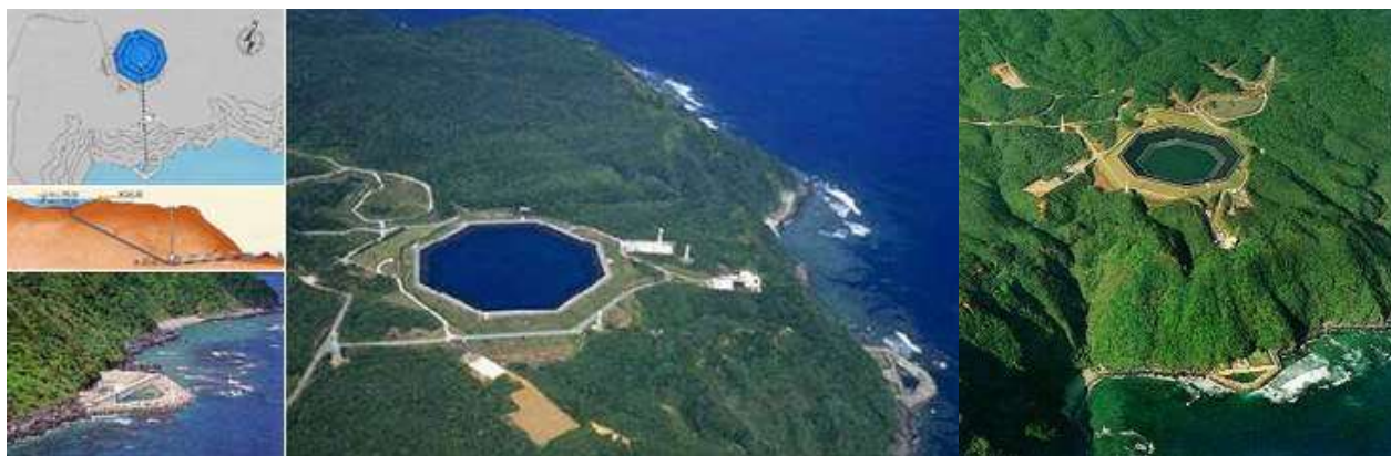
50-расм. Денгиздан юқорида жойлашган ҳажмнинг сувга тўлдирилиши ва сувни қайта ташлаб электроэнергия олиш.
