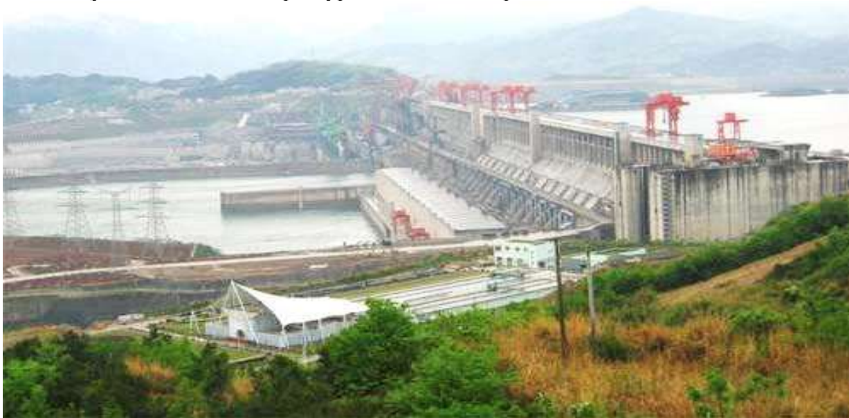
2-расм. Дунёдаги энг катта Уч дара гидроэлектростанцияси
