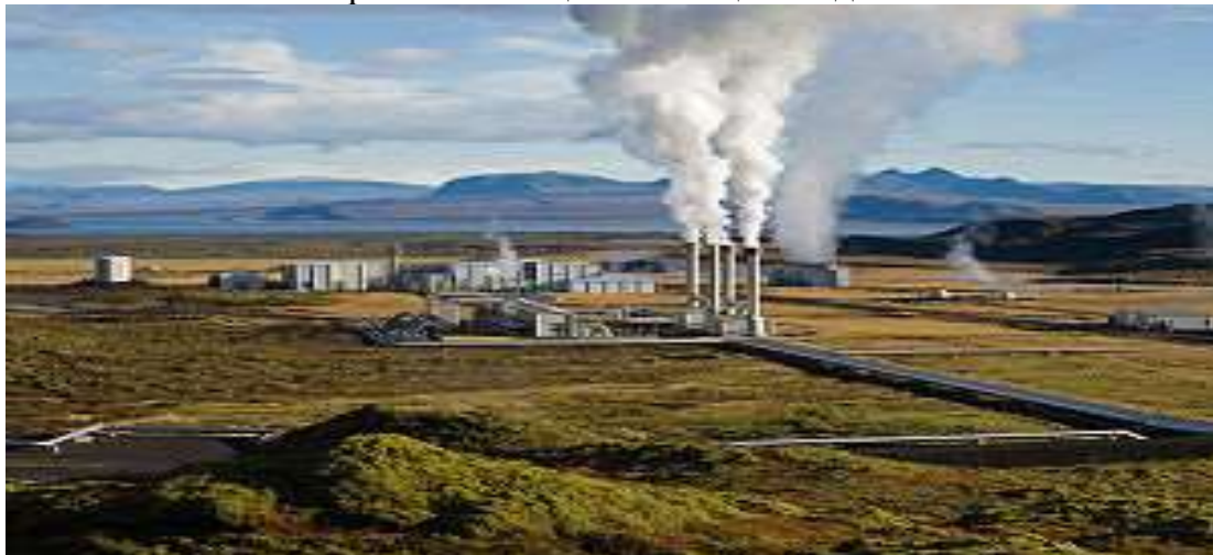
7-расм. Дунёдаги энг катта геотермал электростанцияси.
