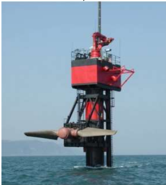
21-расм. Эркин оқим ҳамда океан ва денгизларнинг ички оқимларида ишлайдиган микроГЭСлар
