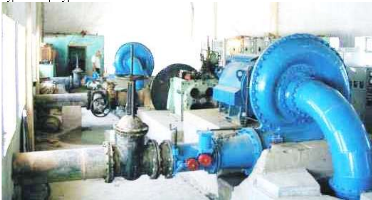
60-расм. Горизонтал радиал-ўқий турбиналар ўрнатилган кичик ГЭС биносининг кўриниши.
