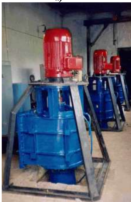
57-расм. 20ПрД парракли диагонал турбинанинг ўрнатилиш схемаси (а) ҳамда ишчи ҳолатидаги кўриниши (б).
