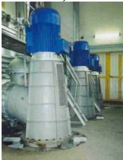
55-расм. Тўғри ўкли конуссимон (а) ва тирсаксимон (б) сўриб кетиш қувурли парракли гидроагрегатлар.
