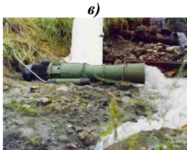
20-расм. Эгилувчан брезент қувурли микро- ГЭС қурилмаларининг кўриниши.
