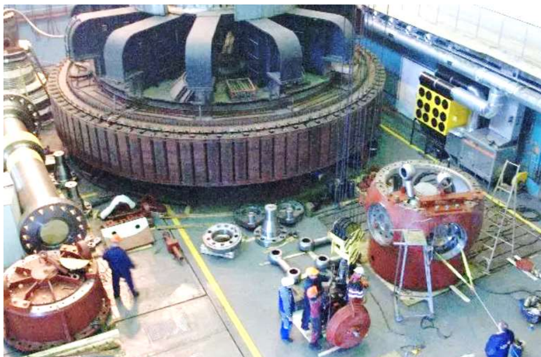
51-расм. ГЭСнинг монтаж майдончаси
