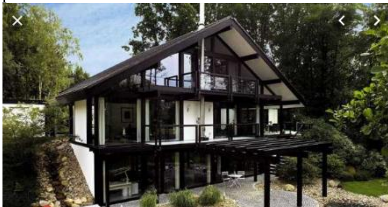
Рис.В2.2. Деревянный каркасный дом по немецкой технологии
