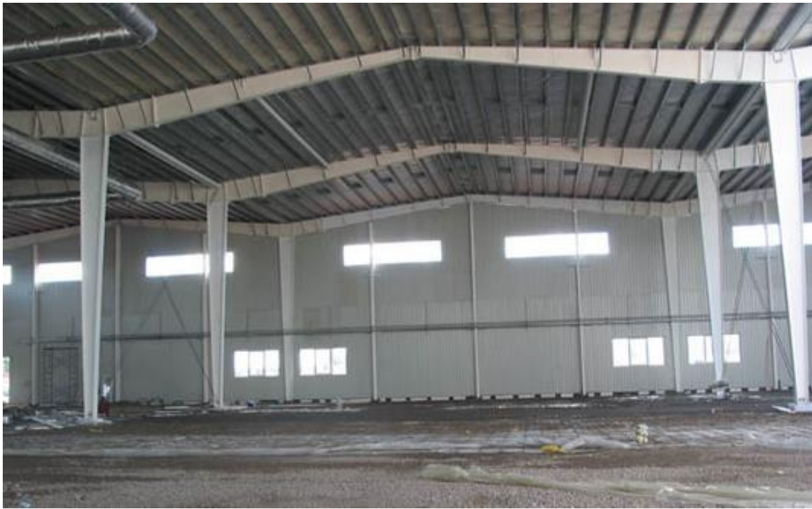
Рис. 2.22. Трёхшарнирная рама сплошного сечения с консолями
