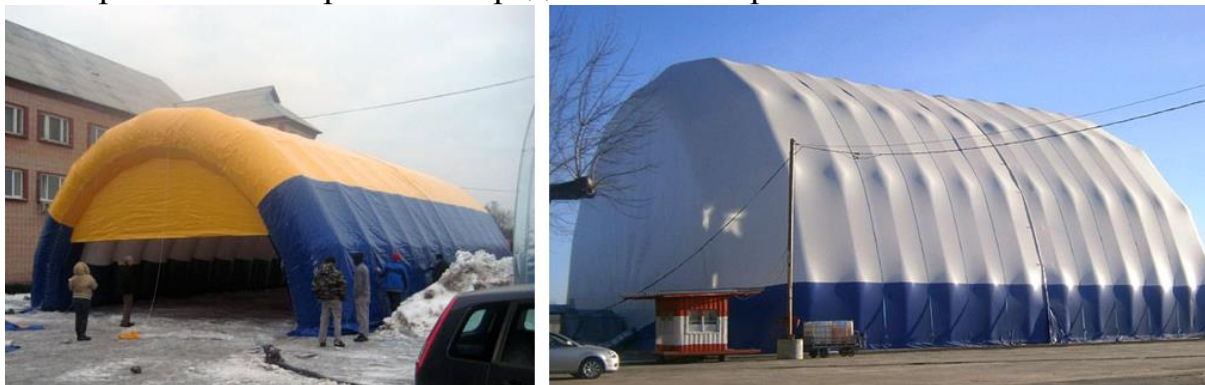
Рис. 2.53. Сооружения с пневмокаркасным покрытием
