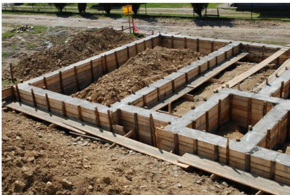
Рис. 1.35. Устройство железобетонного ленточного фундамента
