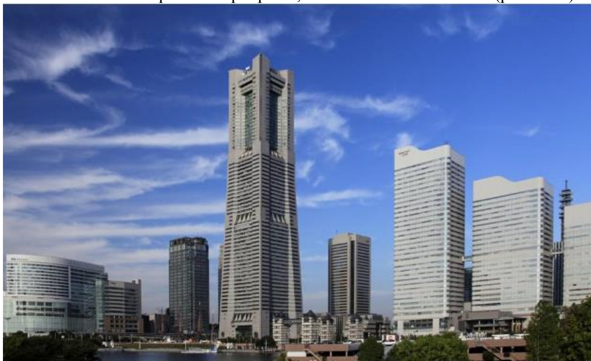
Рис. 3.27. Yokohama Landmark Tower ("Башня-ориентир", Иокогама, Япония)
