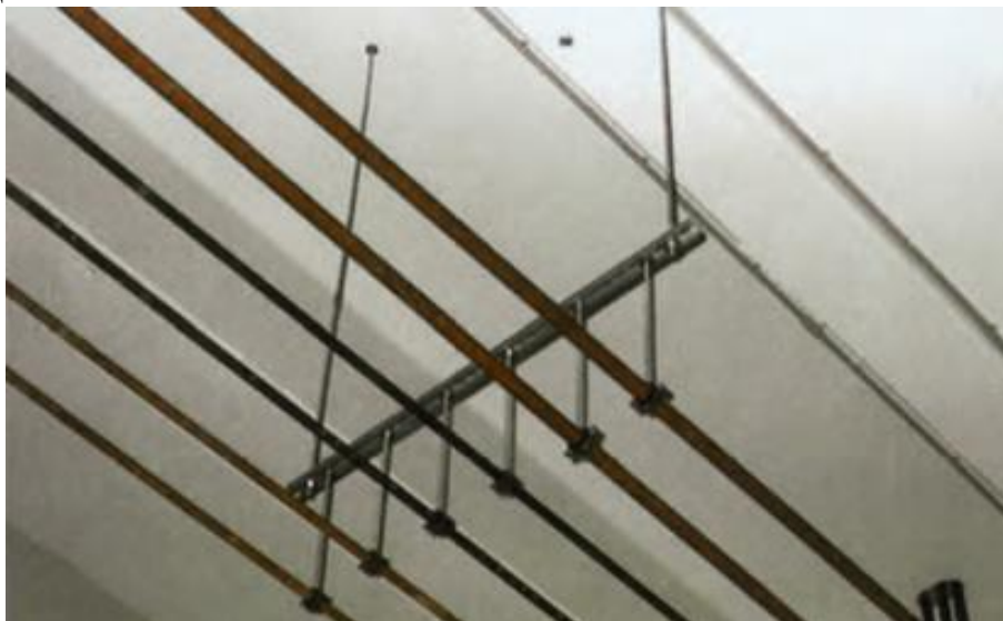
Рис. 3.23. Подвеска трубопроводов, обеспечивающая возможность их трёхмерного перемещения
