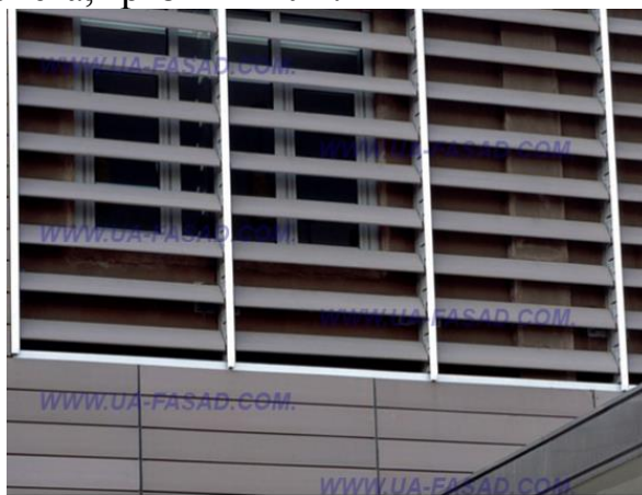
Рис. Пр2.31. Жалюзи с наклонными ламелями
