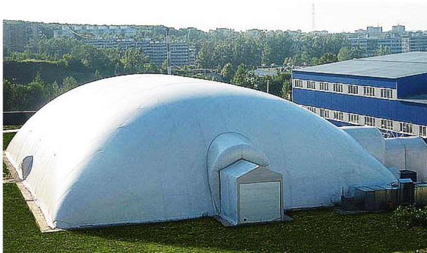
Рис. 2.49. Воздухоопорная однослойная оболочка
