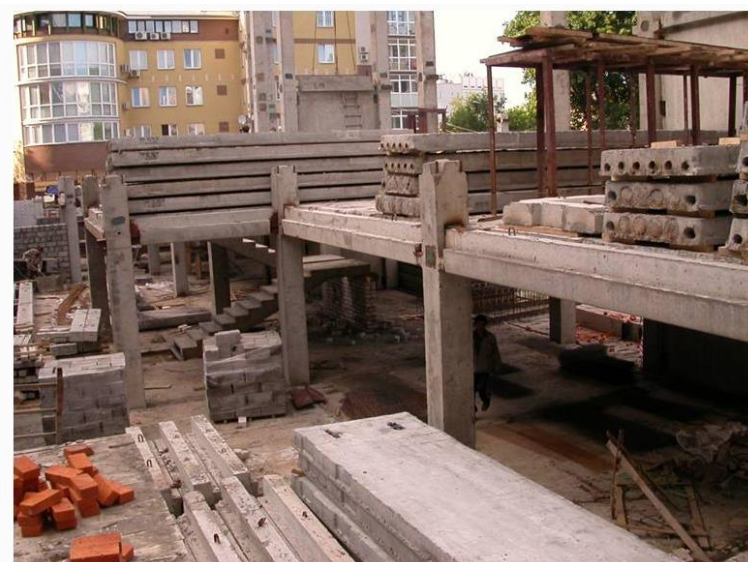
Рис. 1.65. Возведение здания из каркаса серии 1.020.1/87
