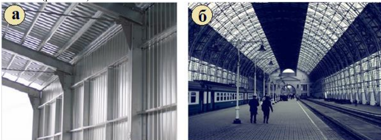
Рис. 2.21. Металлические рамы и арки: а – рама сплошного сечения; б – арка решетчатого сечения
