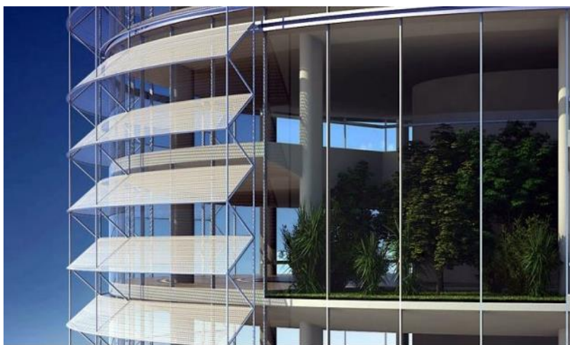
Рис. Пр2.30. Наклонные козырьки
