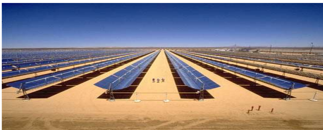
1.6 -расм. Дунёдаги энг катта қуёш электростанцияси.
