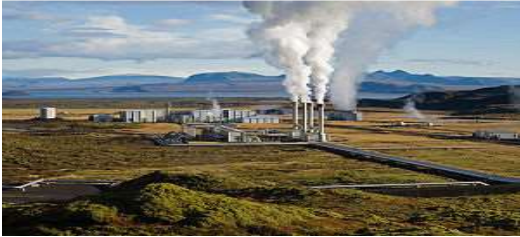
1.7-расм. Дунёдаги энг катта геотермал электростанцияси.
