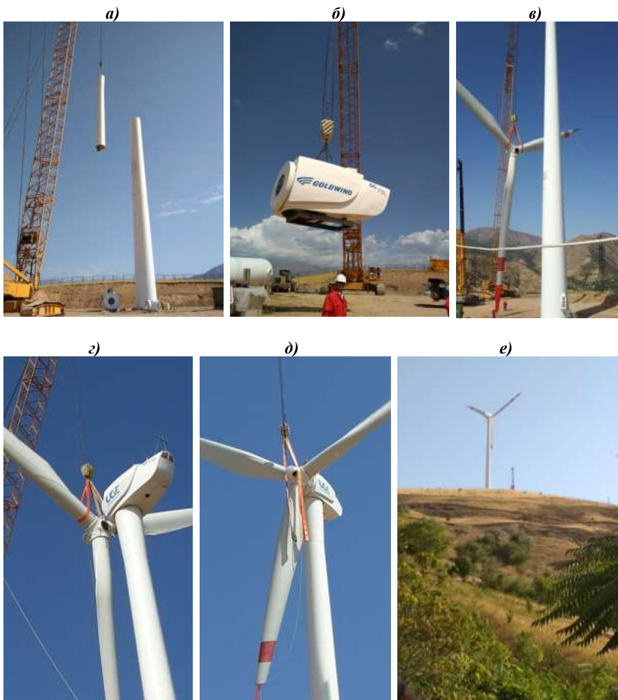
4.9-расм. Жанубий Кореянинг «Doojin Co. LTD» компанияси ёрдамида, Чорвоқ сув омборининг дам олиш зонасида шамол энергоқурилмасини ўрнатиш жараёни
