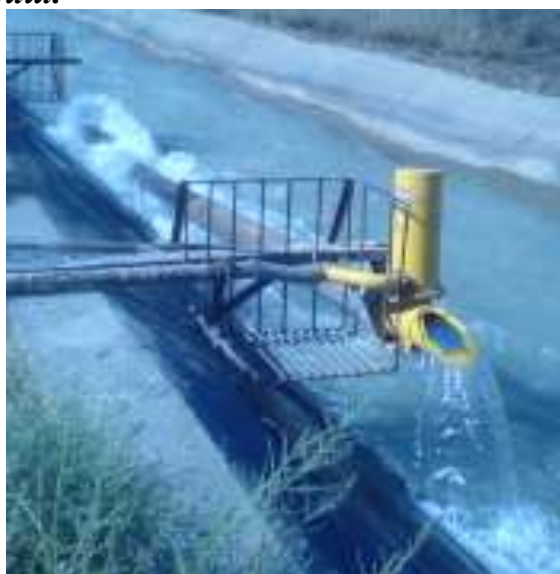
3.7-расм. Канал нишаблиги ҳисобига ўрнатилган гидротаран.
