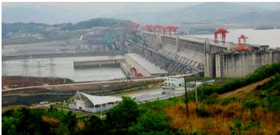
1.2-расм. Дунёдаги энг катта Уч дара гидроэлектростанцияси
