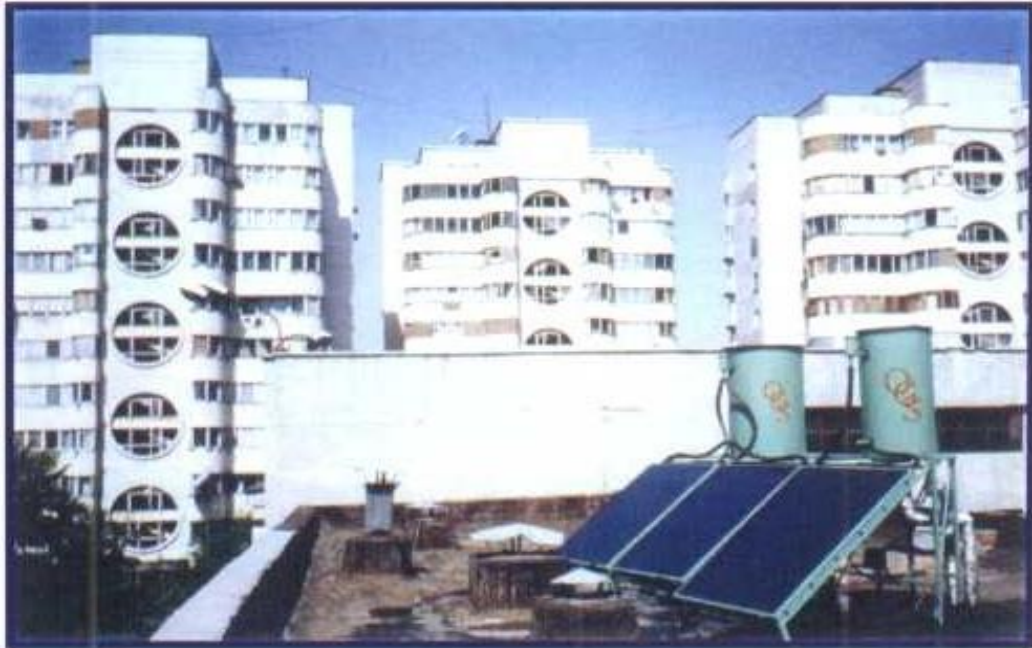
1.2.14-расм. Тошкент шаҳрида поликлиника биноси томига ўрнатилган сув иситгич қурилмалари
