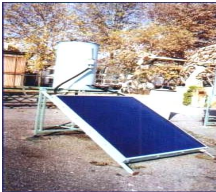
1.2.12- расм. Қуёш иситгичининг сатҳи 2 \text{ м}^2 ва иссиқ сув жамловчи бакининг ҳажми 140 л бўлган 2 контурли сув иситгич қурилма
