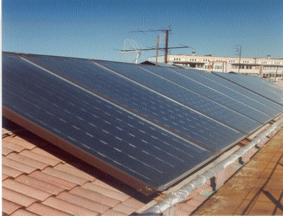
3.1.4-расм. TACIS лойиҳаси бўйича мониторинг ўтказилган Чехов кучасидаги намойиш биносининг томида жойлашган қуёш коллекторлари
