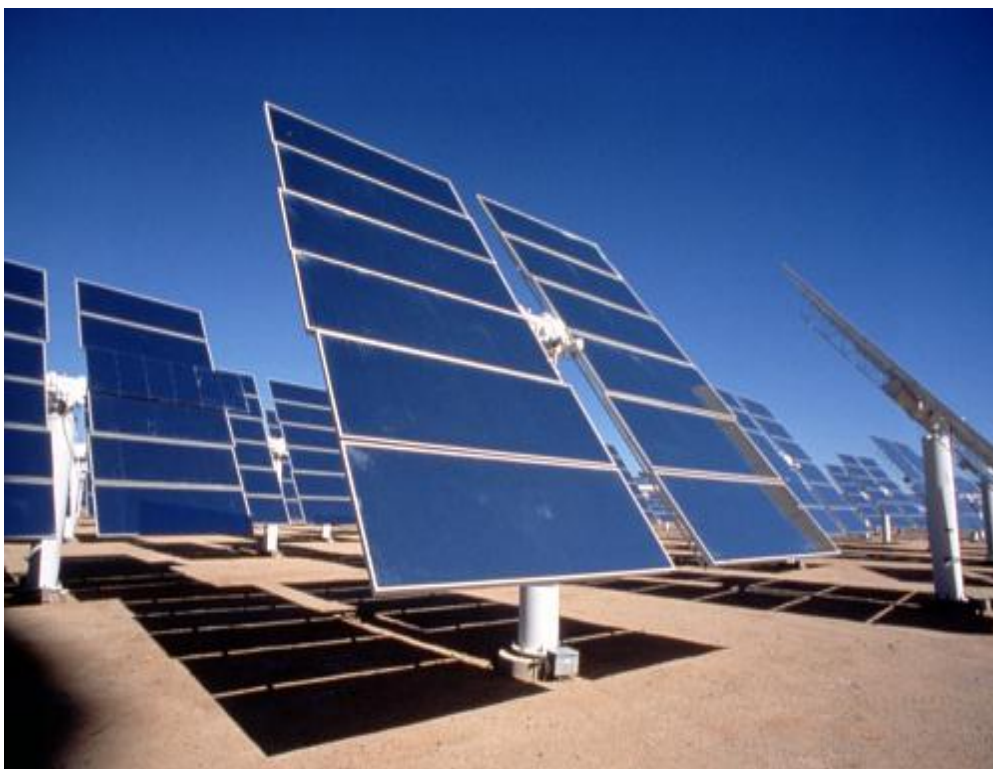
1.1.10-расм. Минорага қаратилган гелиостатларнинг умумий кўриниши
