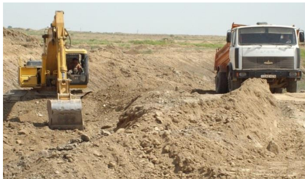
9-расм Грунтни резервда экскаватор билан қазиб автосамосвалга ортиш
