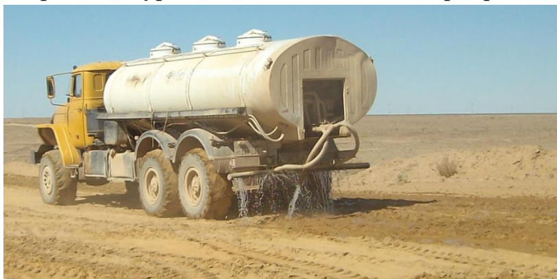
14- расм. Грунт намлигини оптимал қийматга етказиш
