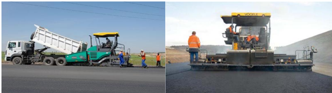
19-расм. Иссиқ асфальтобетон қоришмасини йўлга ётқизиш технологик жараёнида лавхалар.
