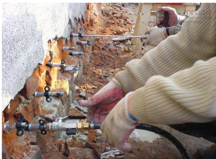
Рис. Пр5.5. Инъектирование каменной кладки ремонтными растворами
