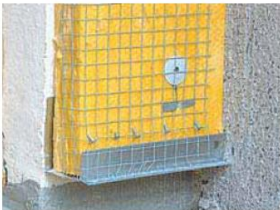
Рис. 4.5. Работы по устройству дополнительной теплоизоляции с толстослойной штукатуркой
