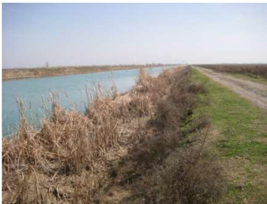
3.2 - расм. Канал қирғоғини ўт босиш ҳолати
