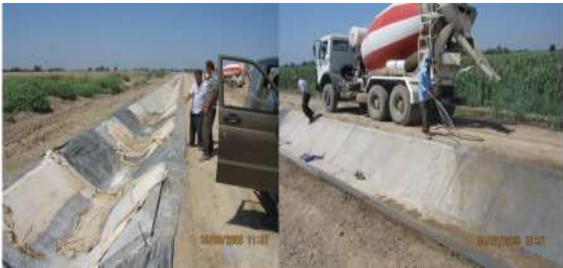
3.14 - расм. Қуйилган бетонга техник қаров ишларини амалга ошириш а) янги қуйилган бетон қопламада биринчи 3 кунгача ўтказиладиган қаров; б) янги қуйилган бетонга 3 ... 7 кун ичида ўтказиладиган техник қаров; 1 – қоплама устига ётқизилган бўз мато; 2 – автобетонқорғич ёрдамида қоплама юзасини намлаш.
