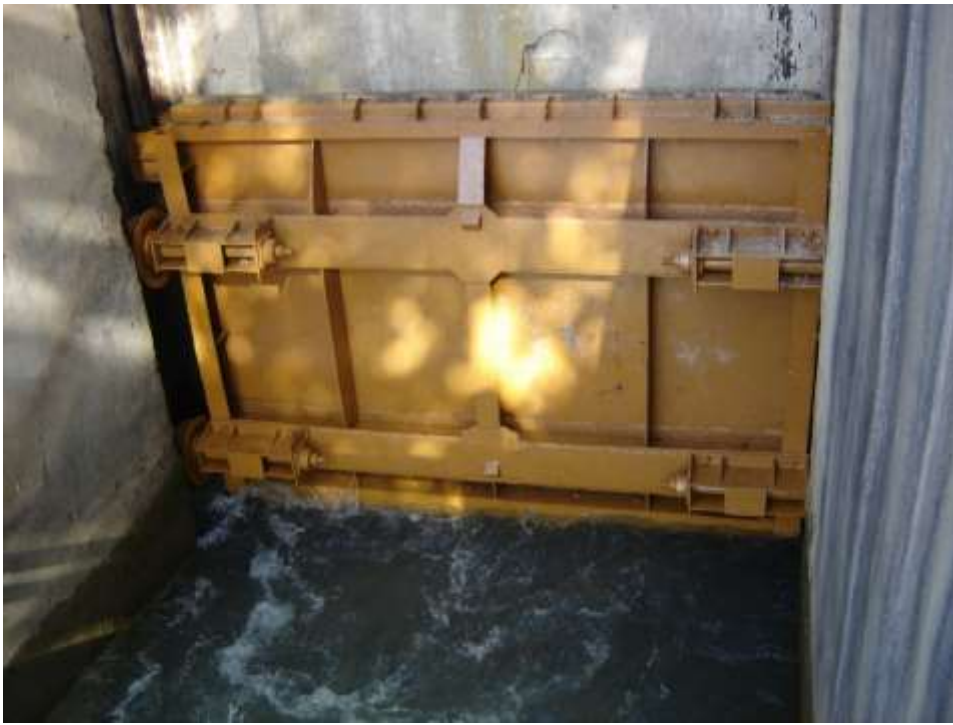
3.15 - расм Катта Фаргона каналнинг бош иншоотига ўрнатилган ясси затворларни пастки бѐфдан кўриниши.
