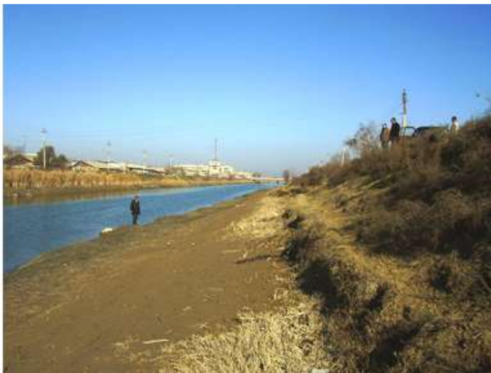
3.8. - расм. Дўстлик каналининг қабарик қисмидаги лойқа чўкиш ҳолати
