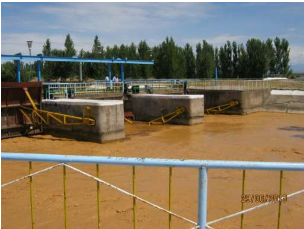
3.16 - расм Катта Фаргона каналига ўрнатилган сегментли затворларни пастки бѐфдан кўриниши.
