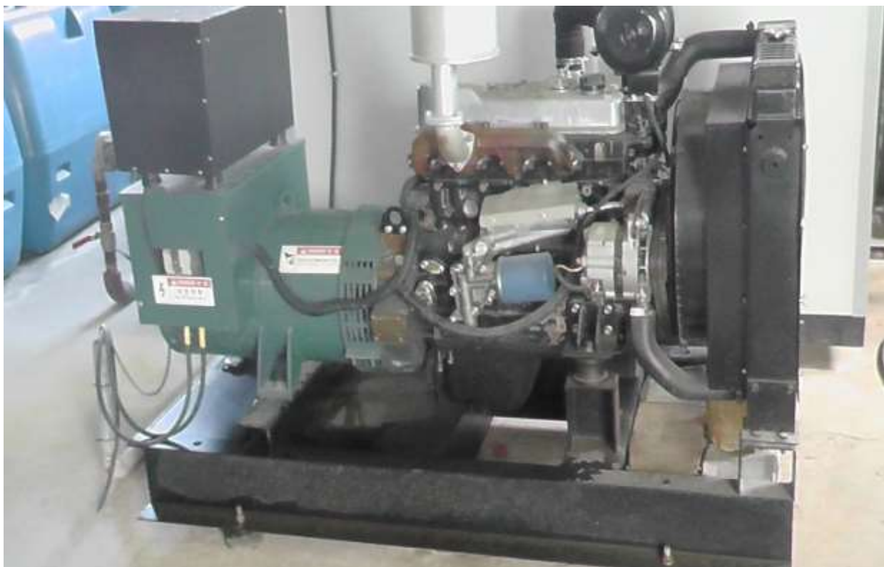
20-расм.Иссикхонада резерв автоном энергия манбаси (35 кВт ли дизел генератори)
