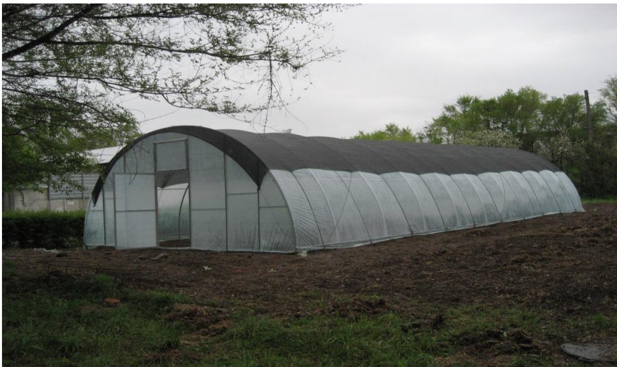
4-расм. Усти плёнка билан ёйсимон қилиб бекитилган ёки нишаби икки томонлама ёпилган иссиқхона.
