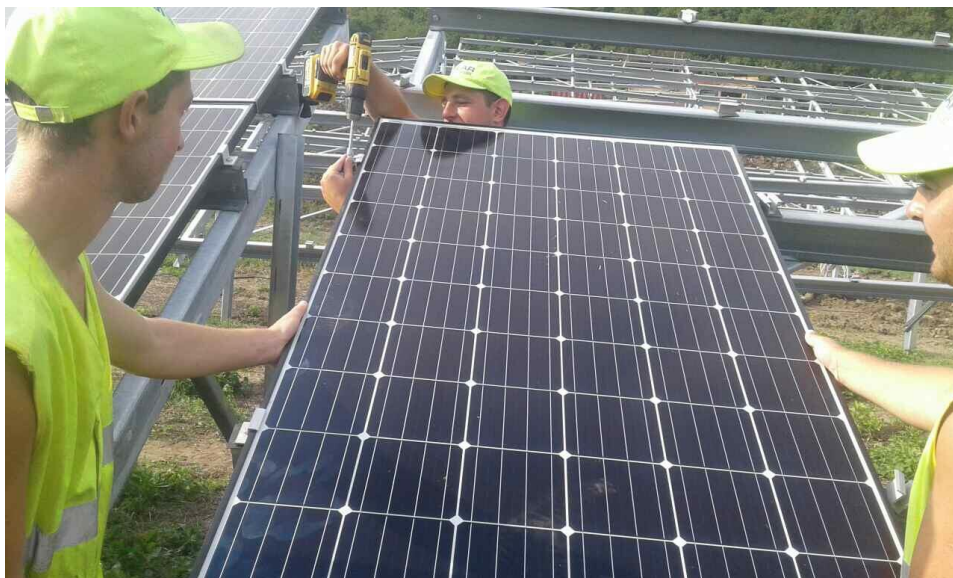
48-расм. Куёш фотоэлектрик станциясида куёш панелларини муҳандислар томонидан ўрнатиш
