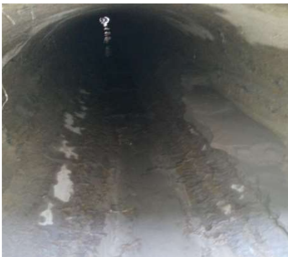
5.1-расм. Диаметри 1420 мм бўлган “Бунёдкор” насос станциялари босимли қувури ҳолати
