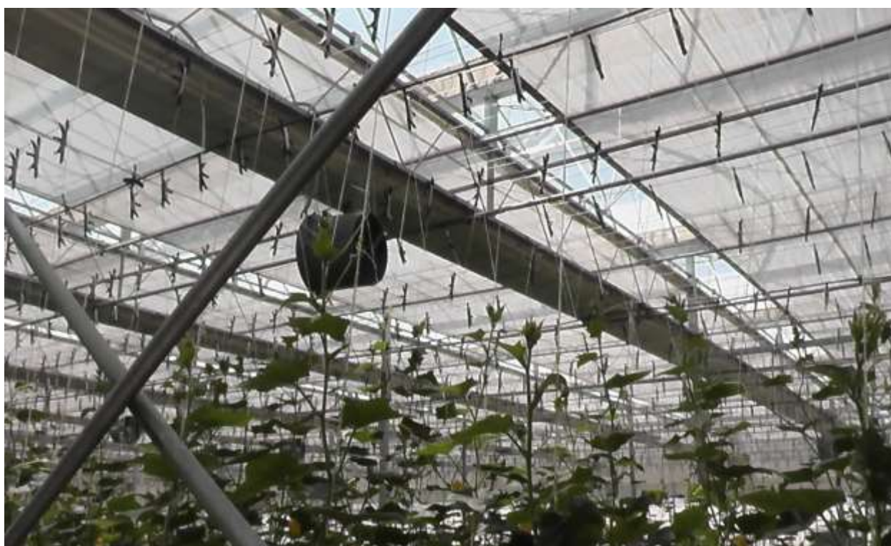
5.10-расм.Теплицада ёруғликни автоматик бошқариш тизими
