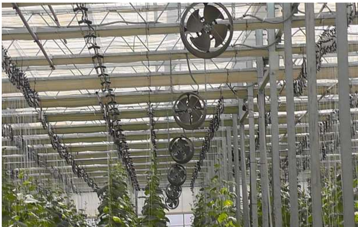
5.11-расм. Теплицада шамоллатиш тизимини автоматик бошқариш тизими
