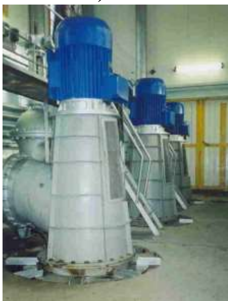
4.4-расм. Тўғри ўкли конуссимон ( a ) ва тирсаксимон ( б ) сўриб кетиш қувурли парракли гидроагрегатлар.
