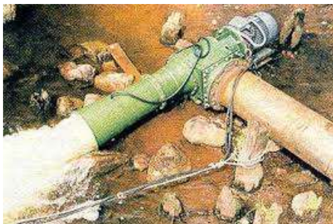
6.2-расм. МикроГЭС 10 Прнинг металл қувурлар (a) ва брезентли қувурлар (b) билан улаб эксплуатация қилиш ҳолатлари.
