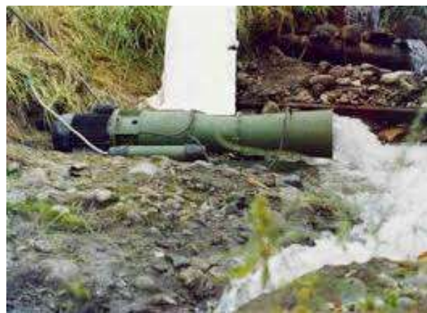
6.2-расм. МикроГЭС 10 Прнинг металл қувурлар (a) ва брезентли қувурлар (b) билан улаб эксплуатация қилиш ҳолатлари.
