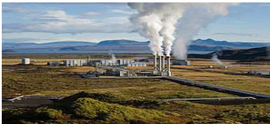
1.7-расм. Дунёдаги энг катта геотермал электростанцияси.
