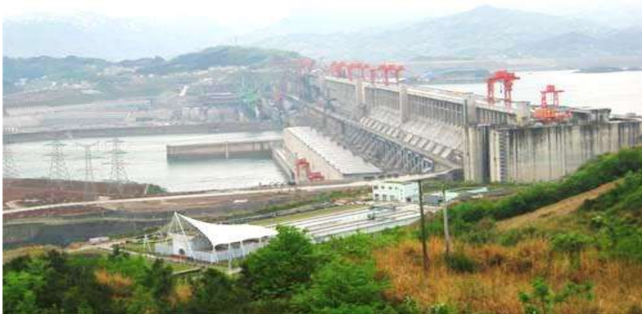
1.2-расм. Дунёдаги энг катта Уч дара гидроэлектростанцияси
