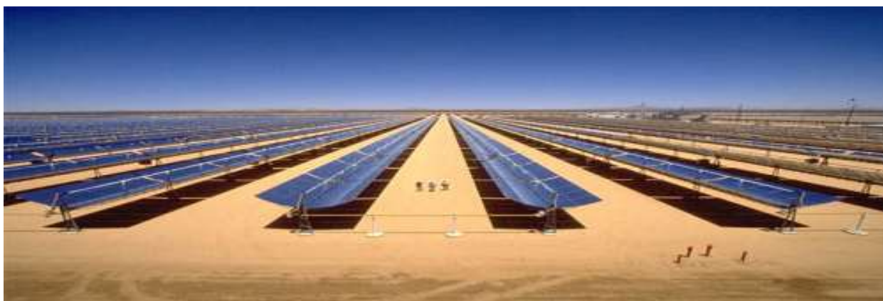
1.6 -расм. Дунёдаги энг катта қуёш электростанцияси.
