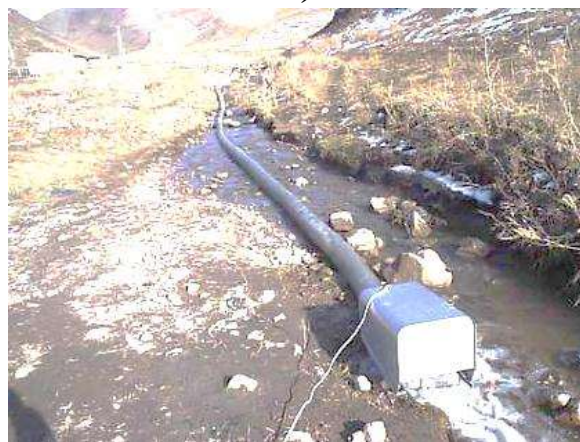
3.4-расм. МикроГЭС 10 Прнинг металл қувурлар (а) ва брезентли қувурлар (б) билан улаб эксплуатация қилиш ҳолатлари.
