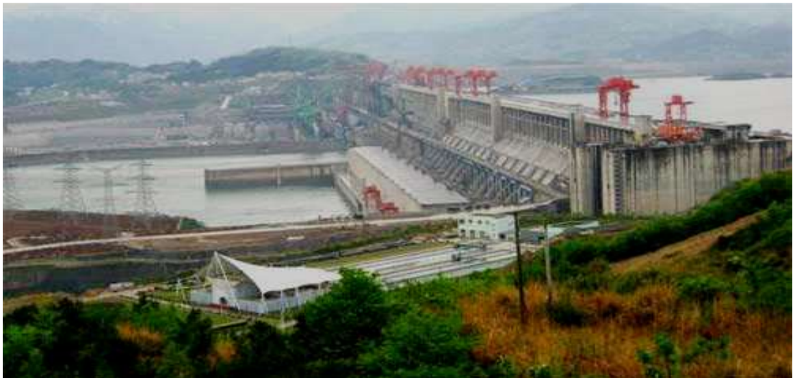
1.2-расм. Дунёдаги энг катта Уч дара гидроэлектростанцияси
