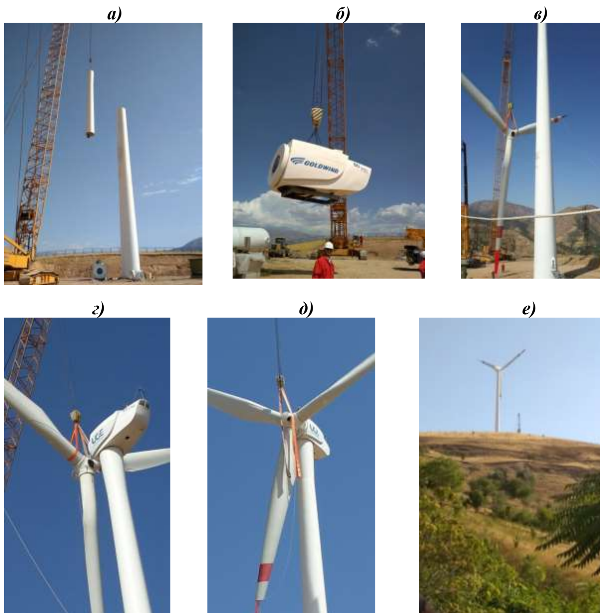
50-расм. Жанубий Кореянинг «Doojin Co. LTD» компанияси ёрдамида, Чорвоқ сув омборининг дам олиш зонасида шамол энергоқурилмасини ўрнатиш жараёни
