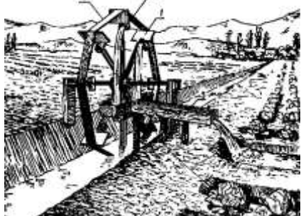
69-расм. Сувнинг гидравлик энергиясидан фойдаланиб сув кўтарувчи мосламалар:
