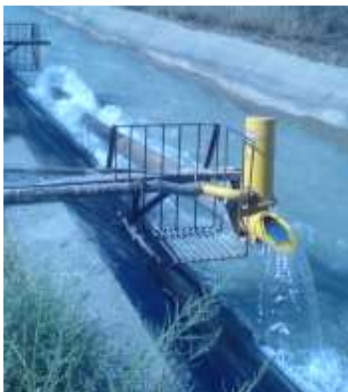
70-расм. Канал нишаблиги ҳисобига ўрнатилган гидротаран.
