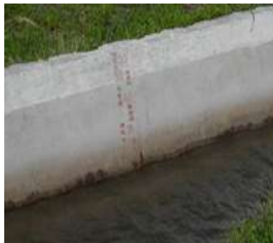
1.10-расм.Стандарт параболик нов.
