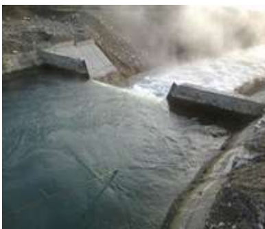
1.11-расм. Сув сарфи 10 м 3 /с га яқин бўлгандаги ўтказгичлардан фойдаланиш жараёни.
