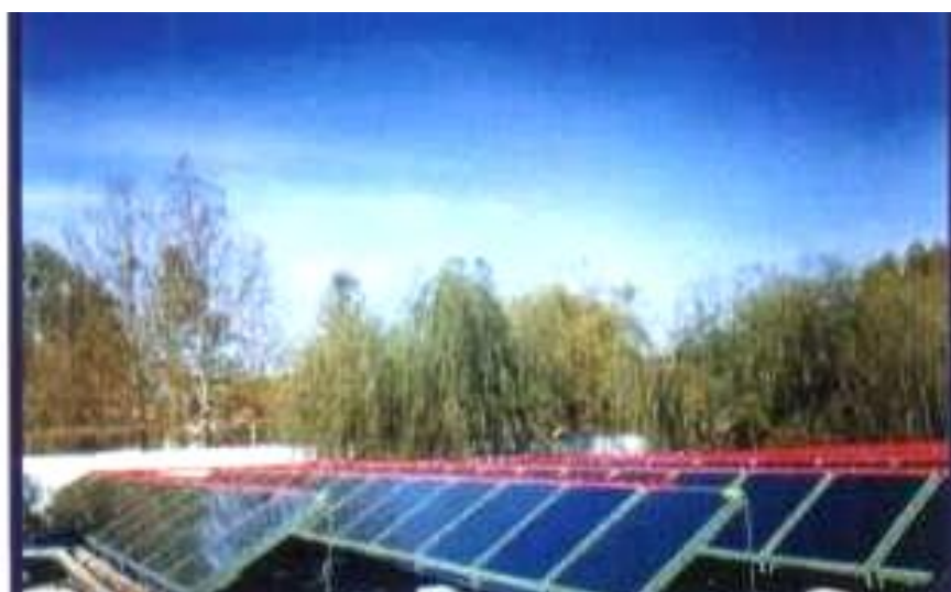
2.16-расм. Анъанавий ёқилғи ҳисобига ишловчи қозонхона ҳудудида жойлашган ва қираётган сувни даслабки иситиб берувчи қуёш сув иситгич қурилмаси
