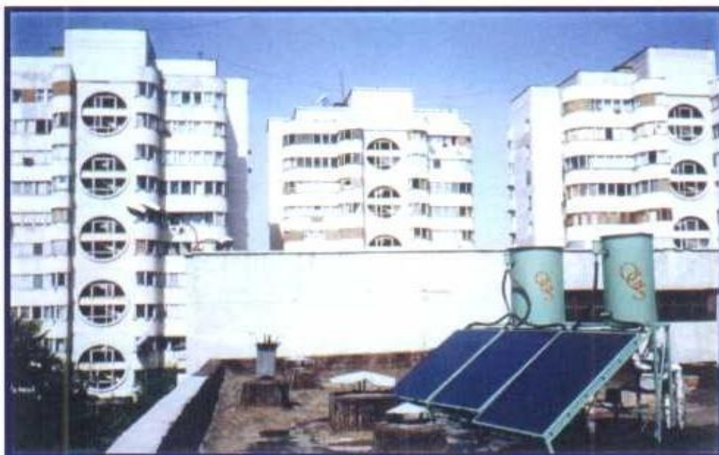
2.14-расм. Тошкент шаҳрида поликлиника биноси томига ўрнатилган сув иситгич қурилмалари
