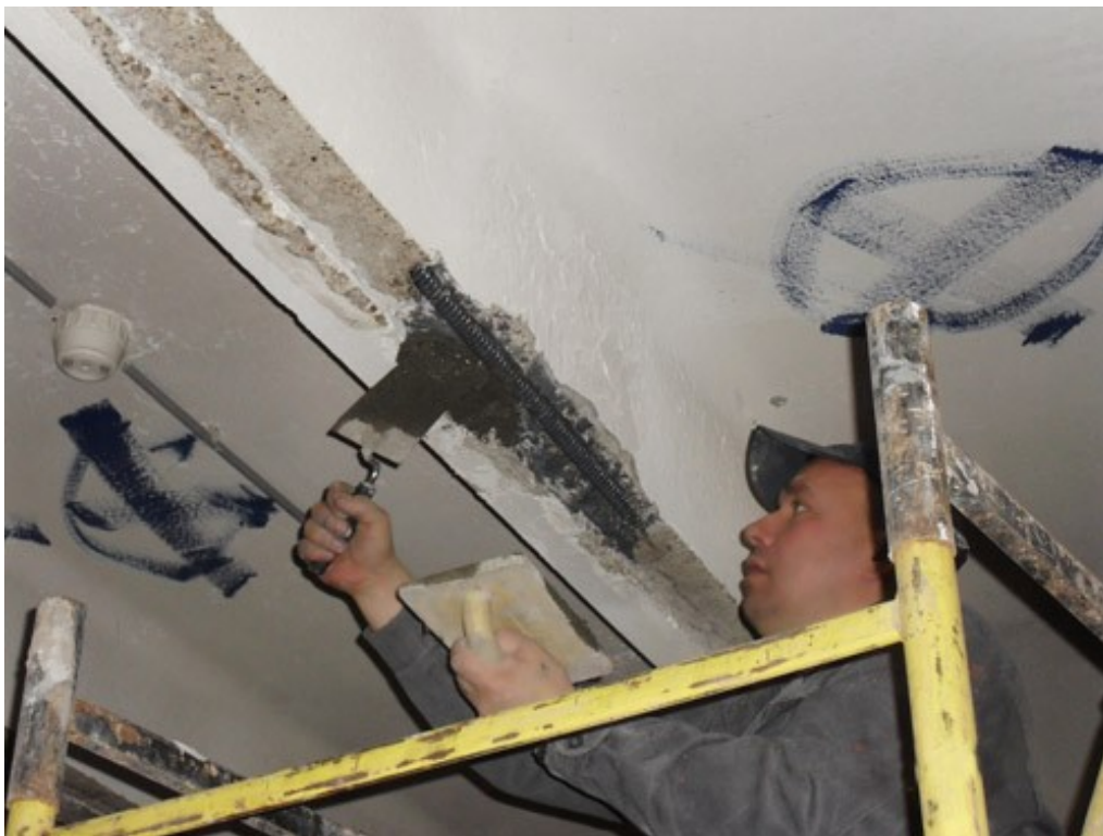
Бетоннинг химоя қатламини полимерцент таркиби билан тиклаш
