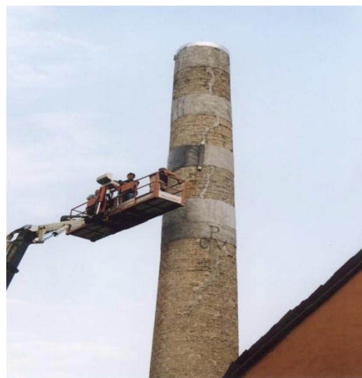
Вертикал ёриқдаги бузулган ғиштли труба
