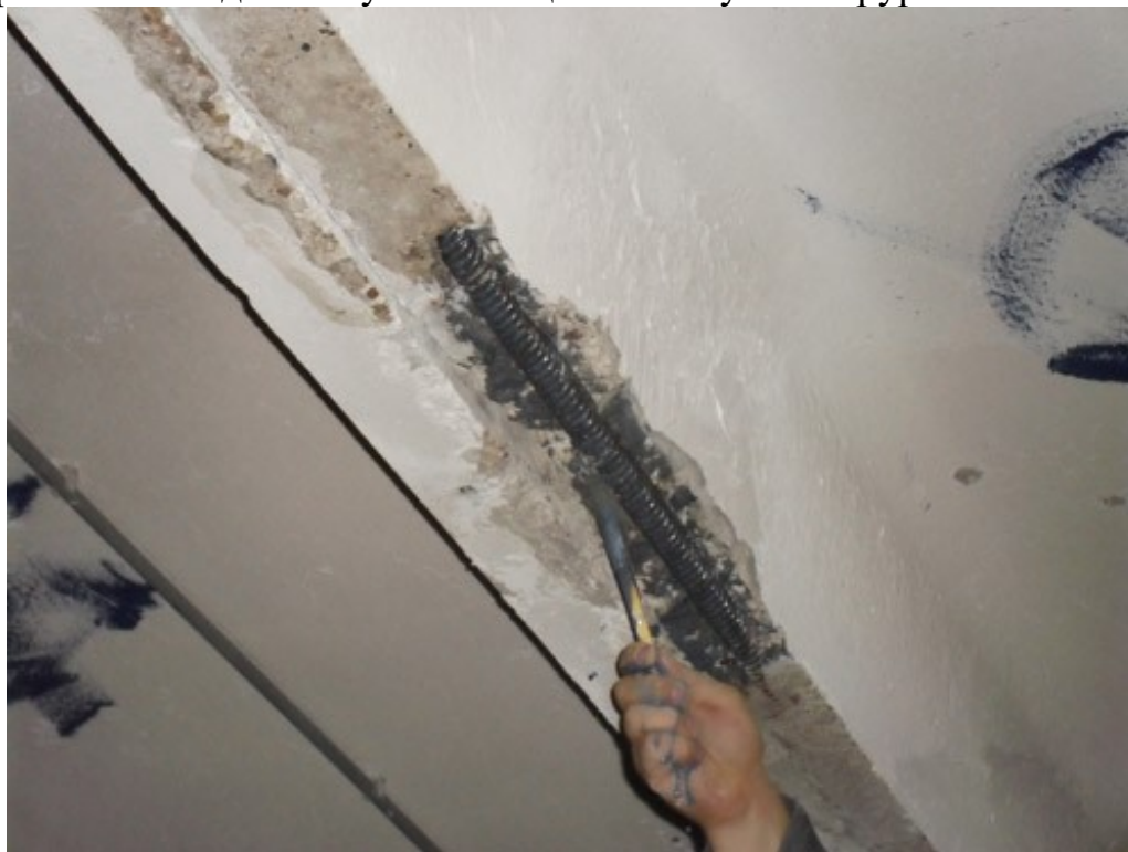
Арматурага антикоррозия таркибини киритиш
