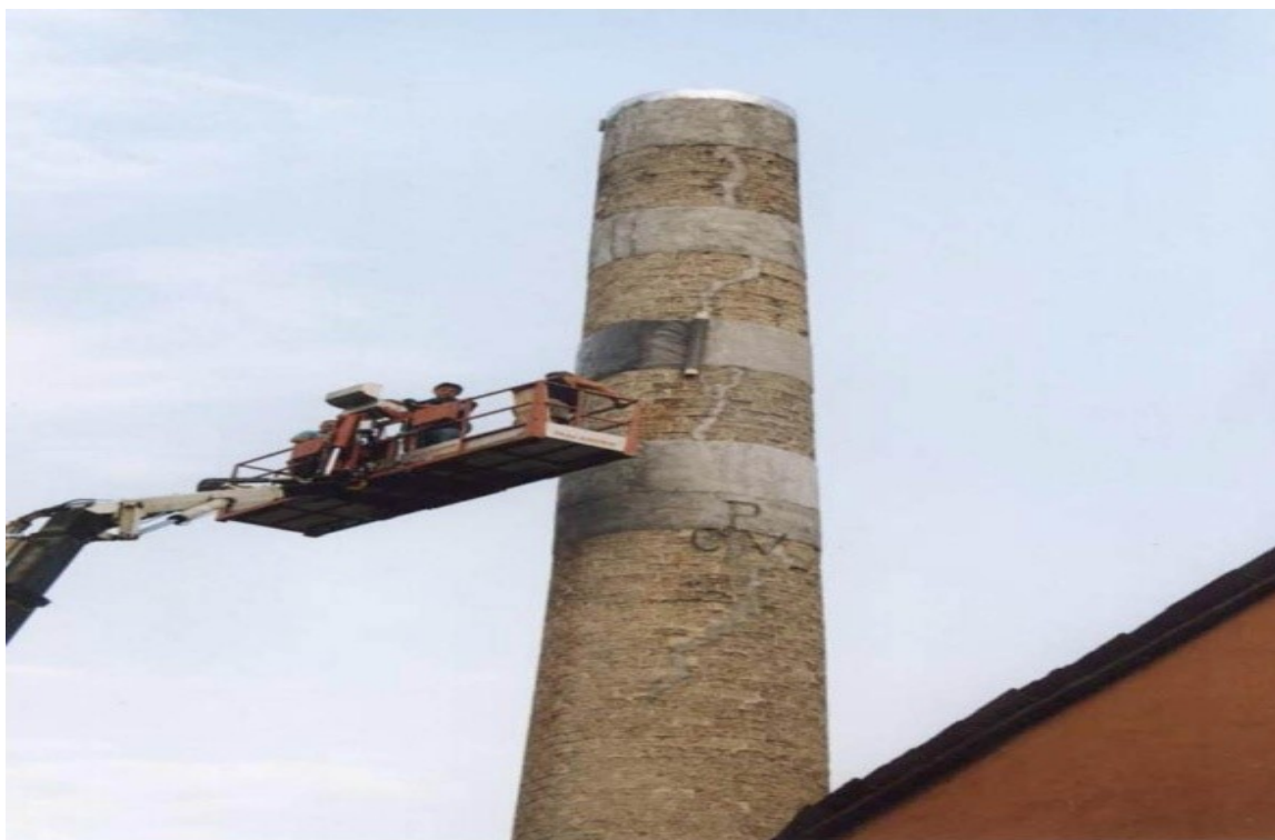
Вертикал ёриқда шикастланиши фойдаланадиган ғишт трубани кучлантириши
