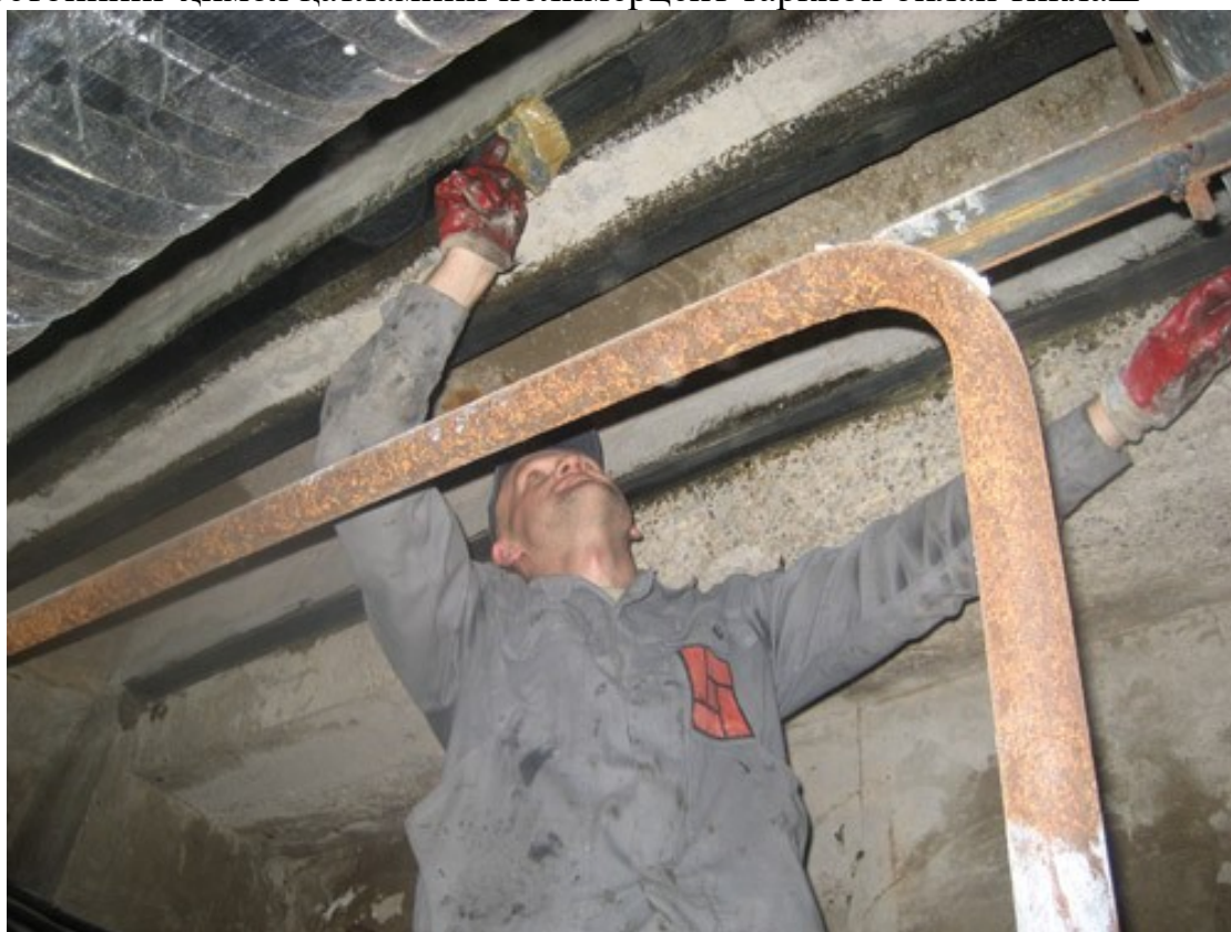
Бетоннинг химоя қатламини полимерцент таркиби билан тиклаш
