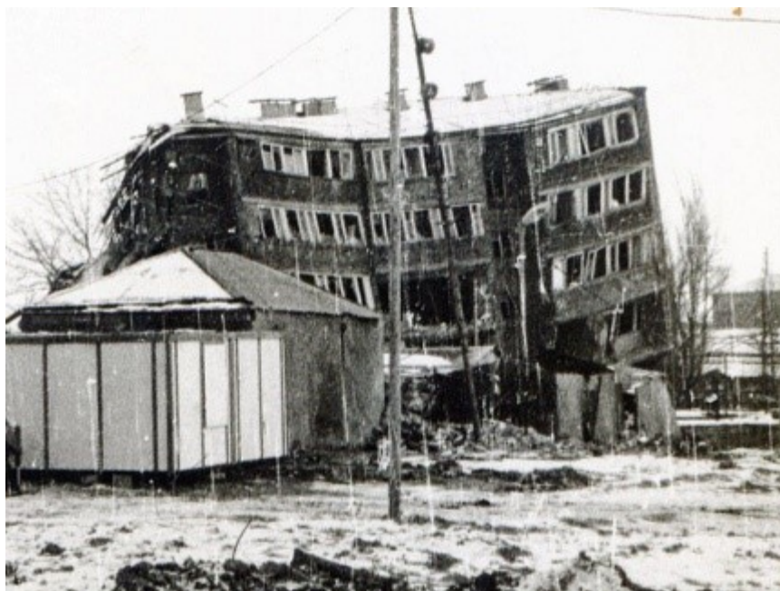
Рис.4.7. Обрушение 5-этажного каменного здания серии 450 с поперечными несущими стенами без средней продольной стены (г. Ленинакан, 1988 г.)
