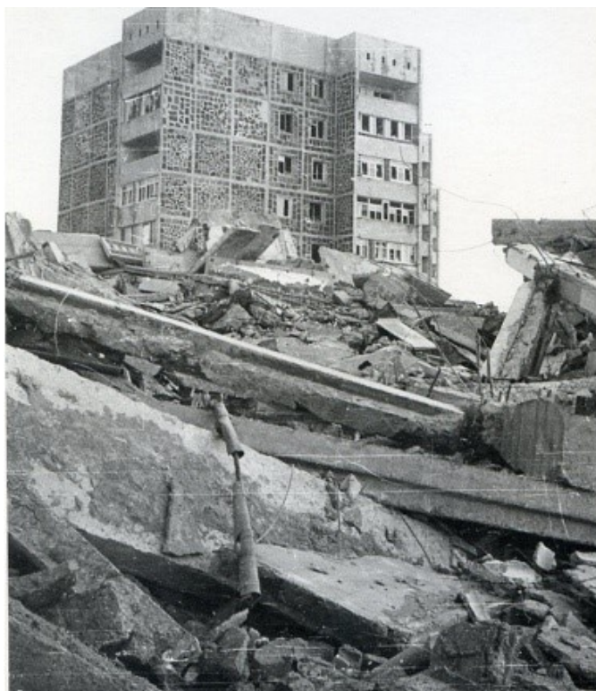
Рис.4.6. Обрушение 9-этажного каркасно-панельного здания серии 111 с различной жесткостью в направлениях главных осей на фоне крупнопанельного здания с легкими повреждениями
