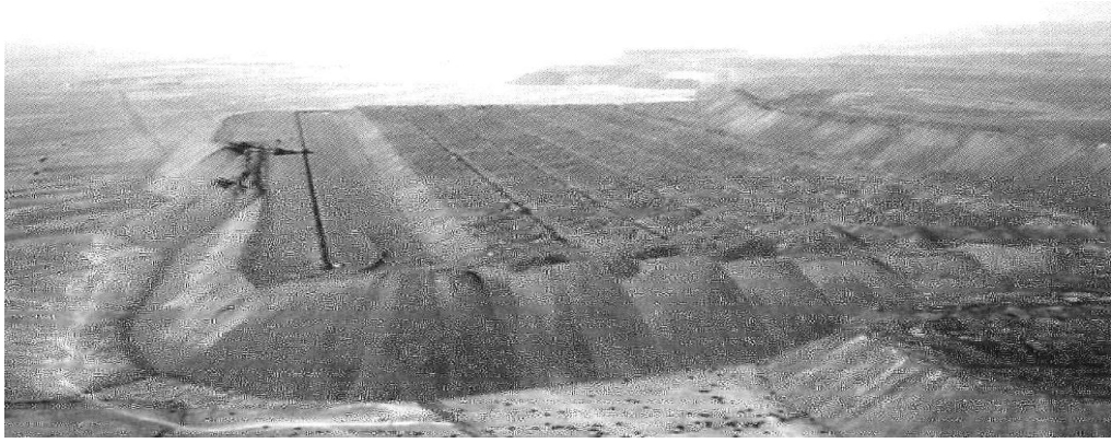
Рис. 1.24.2. Пример формирования нижнего яруса отвала устойчивой высоты
