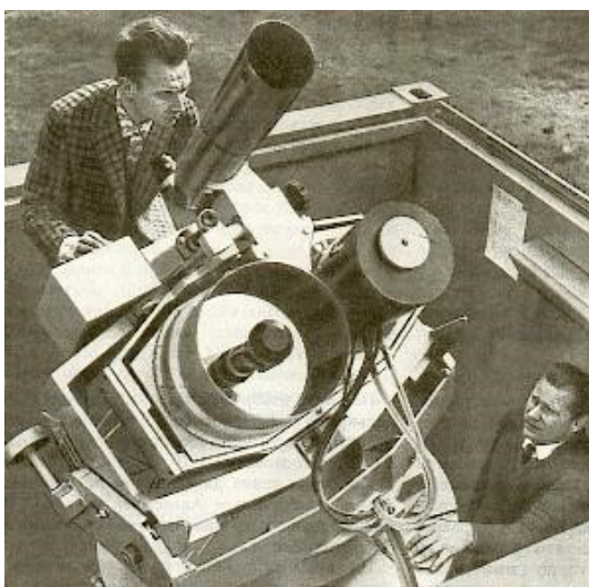
20-расм. “Интеркосмос” лазер узокни ўлчагичи
