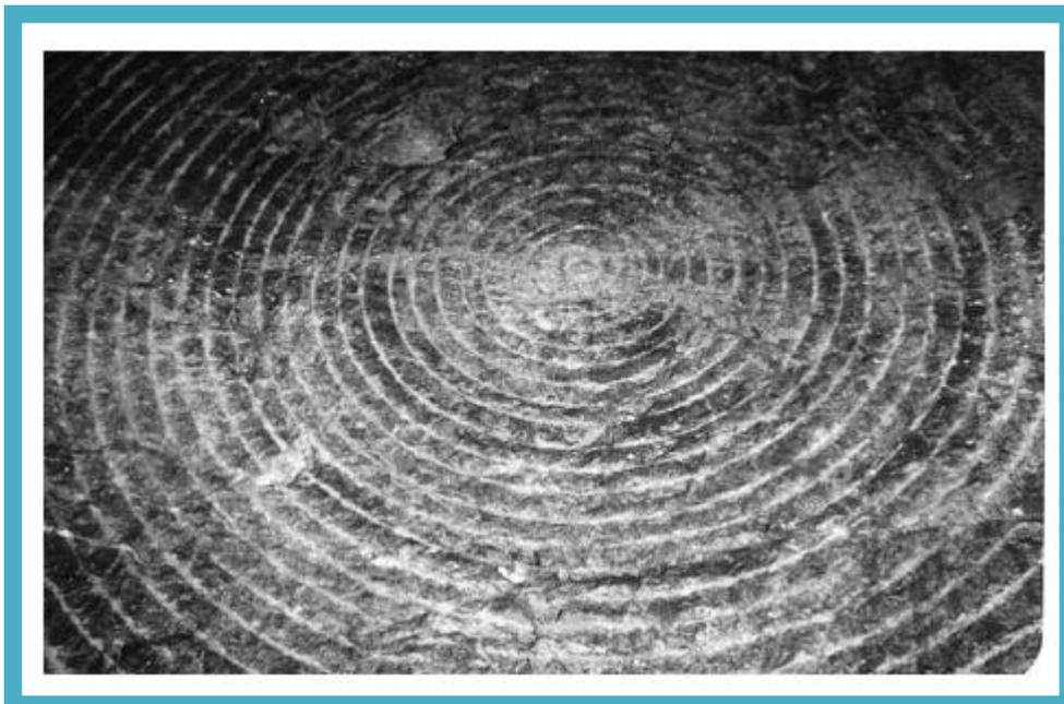
Рисунок 2.2. Вид забоя при проходке дисковыми резцами.
